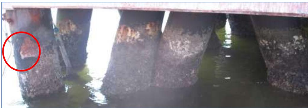
Figuras 2.33: Se aprecia que los microorganismos han retirado consigo parte del recubrimiento.
