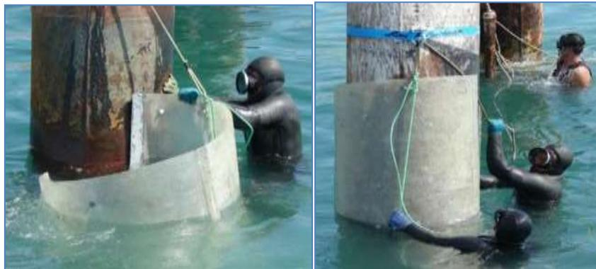
Figuras 3.62 y 3.63: Colocación de chaquetas en el pilote.
