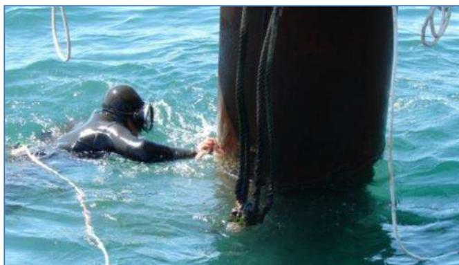
Figura 3.43: Limpieza manual de los pilotes.
