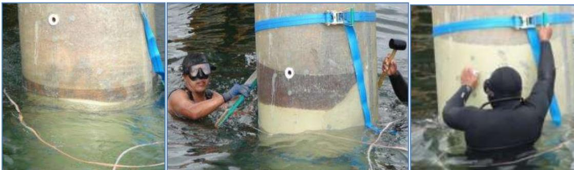
Figuras 3.72, 3.73 y 3.74: Avance del “grout” en la chaqueta translúcida y colocación del tapón en el puerto de inyección.
