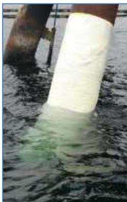
Figura 3.88: Pilote DD63 con el sistema Stopaq aplicado.
