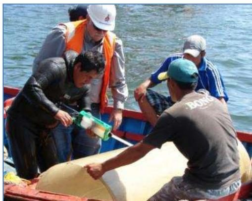
Figura 3.27: Colocación de masilla en la junta.
