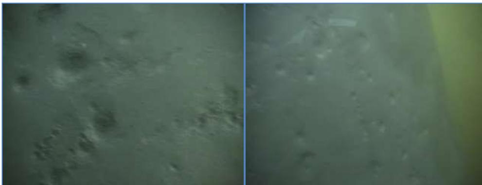
Figuras 2.16 y 2.17: *Pits* en zona de pilotes por debajo de 5 metros del pelo de agua.
