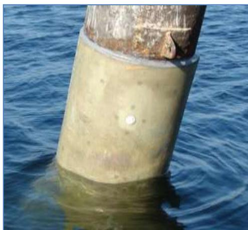
Figura 3.78: Pilote FF65 con el sistema APE aplicado.
