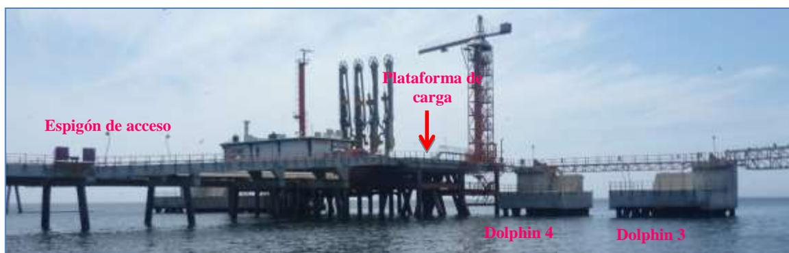
Figura 2.4: Vista del Dolphin 3 y 4, plataforma de carga y espigón de acceso.
