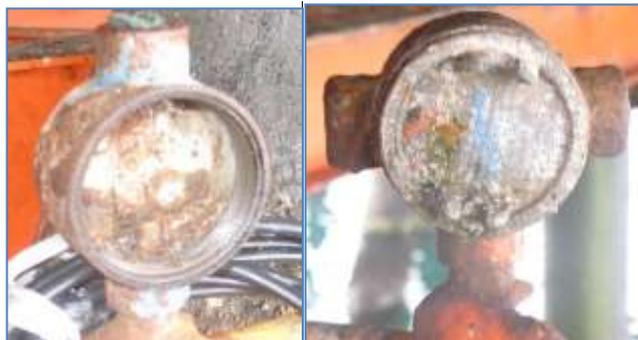
Figuras 2.25 y 2.26: PTP's con evidente corrosión.
