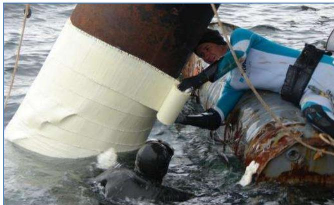
Figura 3.85: Aplicación de cinta envolvente de fibra de vidrio (*Outerglass Shield* XT24) sobre el nivel del mar.
