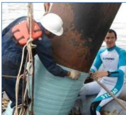
Figura 3.83: Aplicación de la cinta envolvente atmosférica (*Stopaq Wrappingband CZ(H)*).
