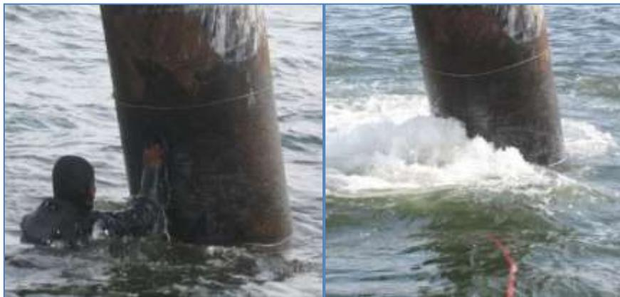
Figuras 3.14 y 3.15: Limpieza manual y limpieza hidráulica.
