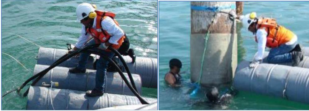
Figuras 3.70 y 3.71: Maniobras para el ajuste de la manguera en el puerto inferior.
