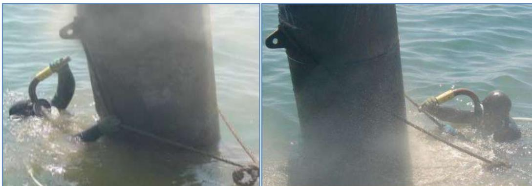
Figuras 3.57 y 3.58: Arenado de la superficie de pilote.
