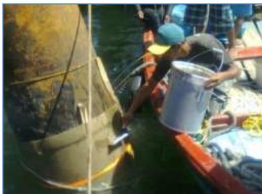
Figura 3.32: Vaciado de “grout” en chaqueta inferior.
