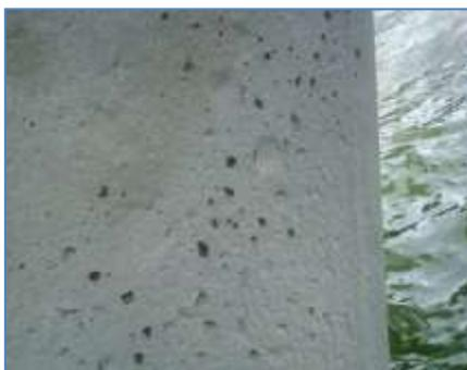
Figura 2.11: Pilote arenado
