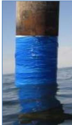
Figura 3.23: Pilote FF74 con el sistema “Symtho shield” aplicado.
