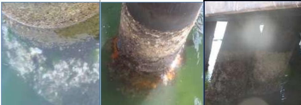
Figuras 2.30, 2.31 y 2.32: Caliche adherido en la zona *splash* de los pilotes.
