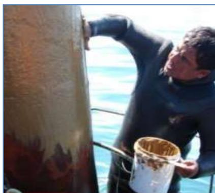
Figura 3.44: Aplicación del *primer* en la parte aérea.
