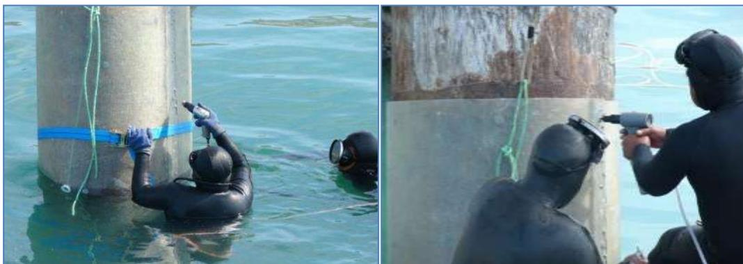
Figuras 3.64 y 3.65: Ajuste de la chaqueta con remachador neumático.
