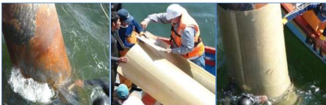
Figuras 3.33, 3.34 y 3.35: Limpieza del pilote, aplicación de la masilla y colocación de la chaqueta superior.
