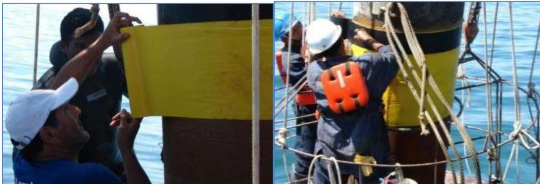
Figuras 3.46 y 3.47: Aplicación de la cinta de PVC y colocación de la cinta Stopaq.
