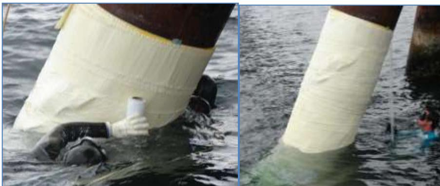
Figuras 3.86 y 3.87: Aplicación y retiro de la filmina de compresión.
