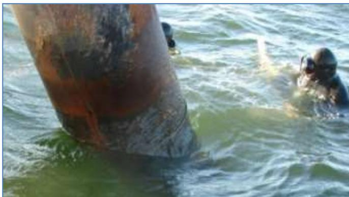
Figura 3.26: Limpieza manual del pilote.
