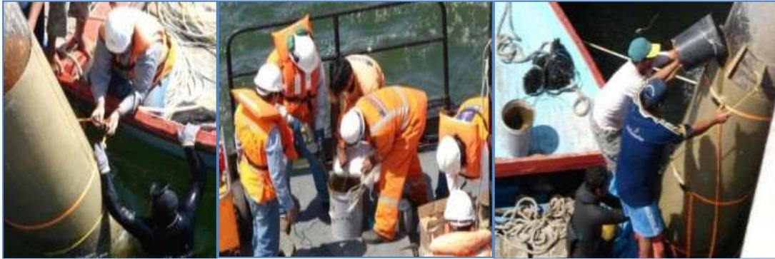
Figuras 3.37, 3.38 y 3.39: Colocación de correas, preparación del “grout” y vaciado en chaqueta superior.
