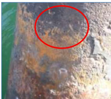
Figura 2.34: Se aprecia que los microorganismos han retirado consigo parte del recubrimiento.
