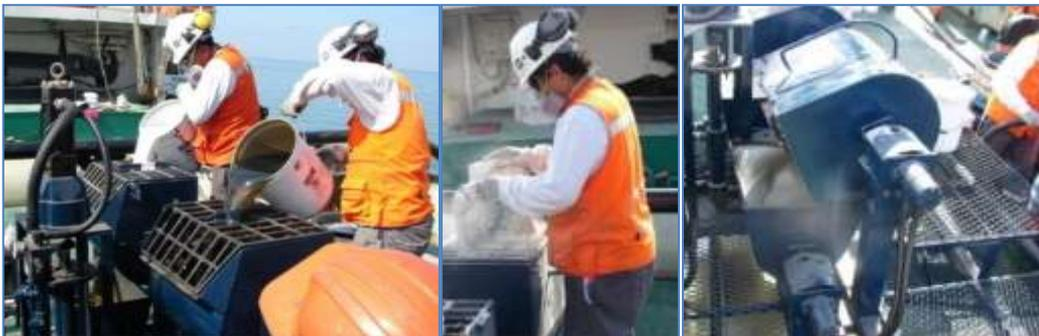
Figuras 3.67, 3.68 y 3.69: Agregado de los componentes A, B y C en la elaboración del “grout”.
