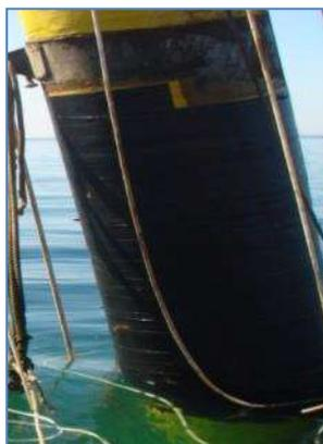
Figura 3.48: Pilote NN70 con el sistema Shaic & Stopaq aplicado.
