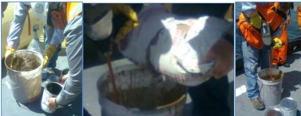
Figuras 3.29, 3.30 y 3.31: Mezcla de los componentes A/B y Epoxy Hidro Ester.
