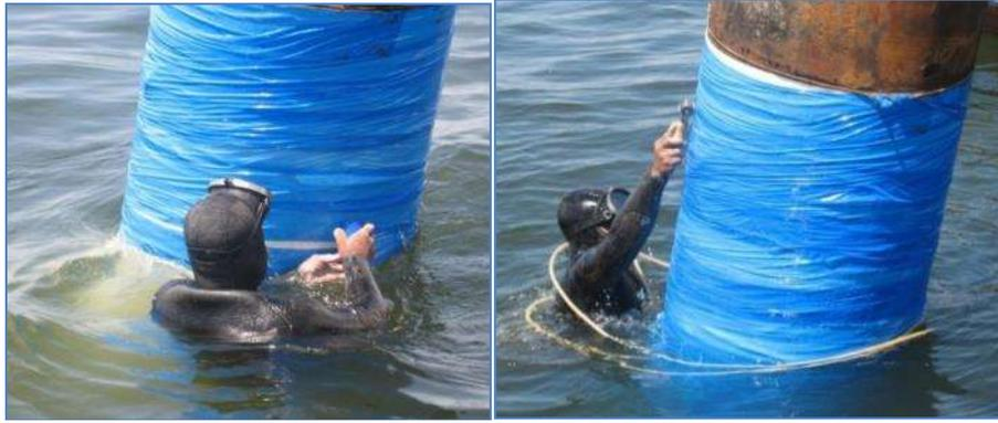
Figuras 3.21 y 3.22: Colocación y perforación de la cinta de compresión.
