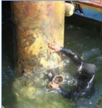
Figura 3.5: Aplicación del “*pile primer*”.
