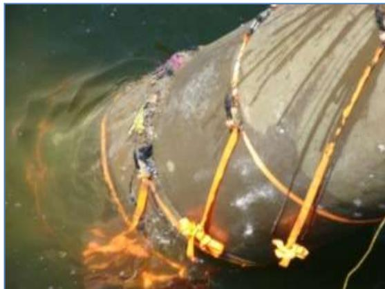
Figura 3.41: Pilote DD72 con el sistema FX – 70 aplicado.
