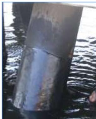
Figura 2.18: Pilote enmasillado. Figura 2.19: Trabajo de enmasillado de un pilote.
