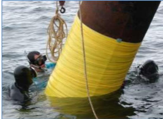
Figura 3.84: Aplicación de cinta envolvente exterior amarilla de PVC (*Yellow Outerwrap* PVC).
