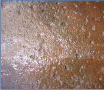
Figura 2.12: Superficie de pilote afectada por *pits*.
