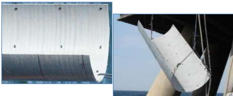
Figuras 3.91 y 3.92: Disposición de los separadores y maniobras para posicionamiento de chaqueta.
