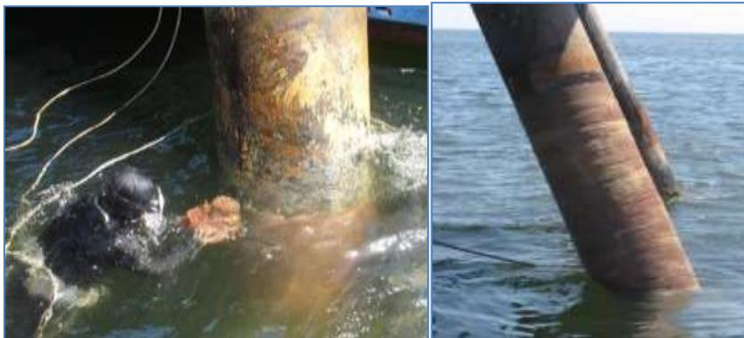
Figuras 3.6 y 3.7: Colocación del “*inner wrap*” y aplicación finalizada.
