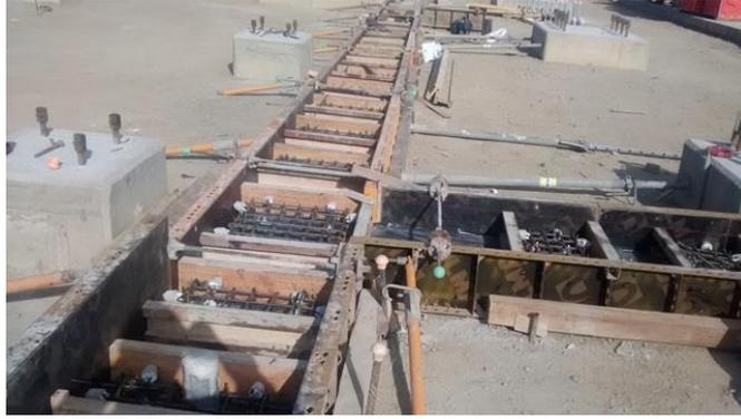
Figura 28. Encofrado y colocado de acero de tapas In-Situ.
