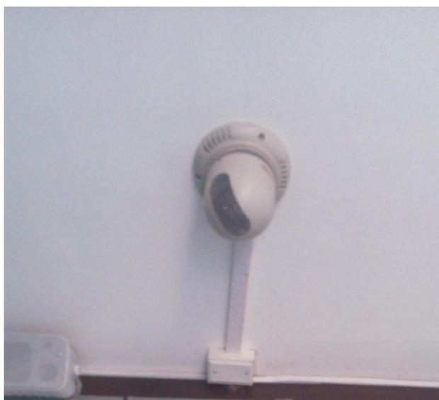
**Figura 5.6: Cámara de seguridad instalada en la empresa en estudio.
