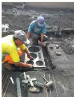
**Figura 30.** Modelo de hierro fundido, de una sola pieza.
