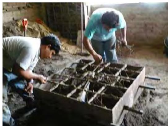
**Figura 35.**Colocación de refuerzos para el moldeo de una pieza grande.
