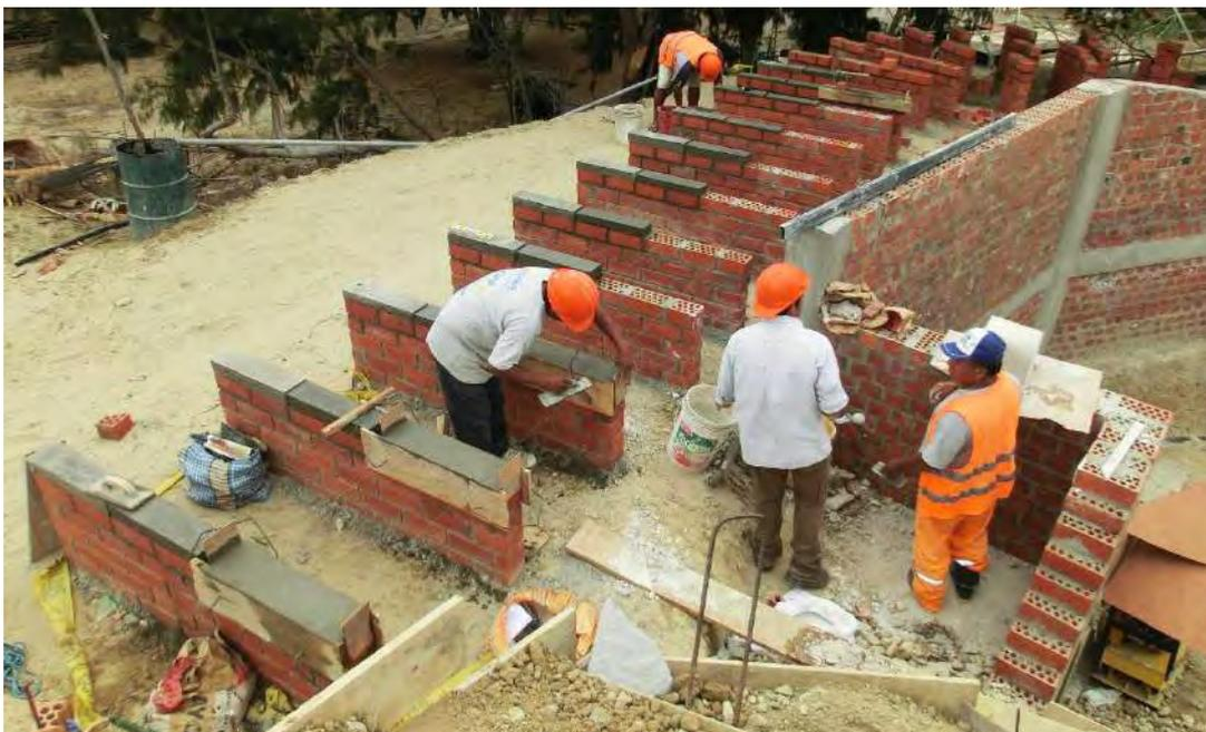
Figura 91. Construcción de los pilares para los túneles de vertedero
