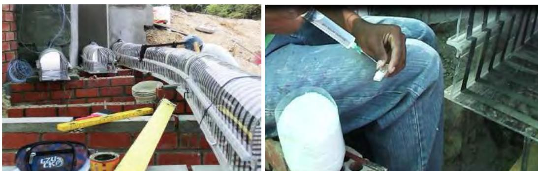
Figura 102. Instalación y empalme de las secciones de los túneles de vertedero
