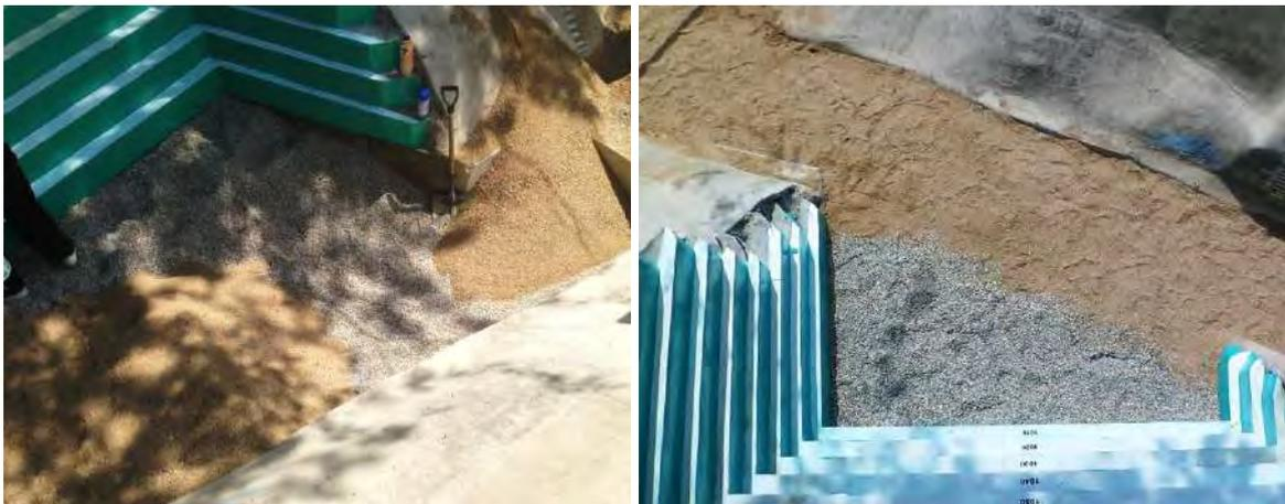
Figura 66. a) Colocación y b) disposición final de sedimentos en la poza disipadora
