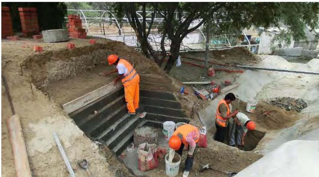
Figura 108. Zona aguas abajo terminada, durante la construcción del cuenco amortiguador
