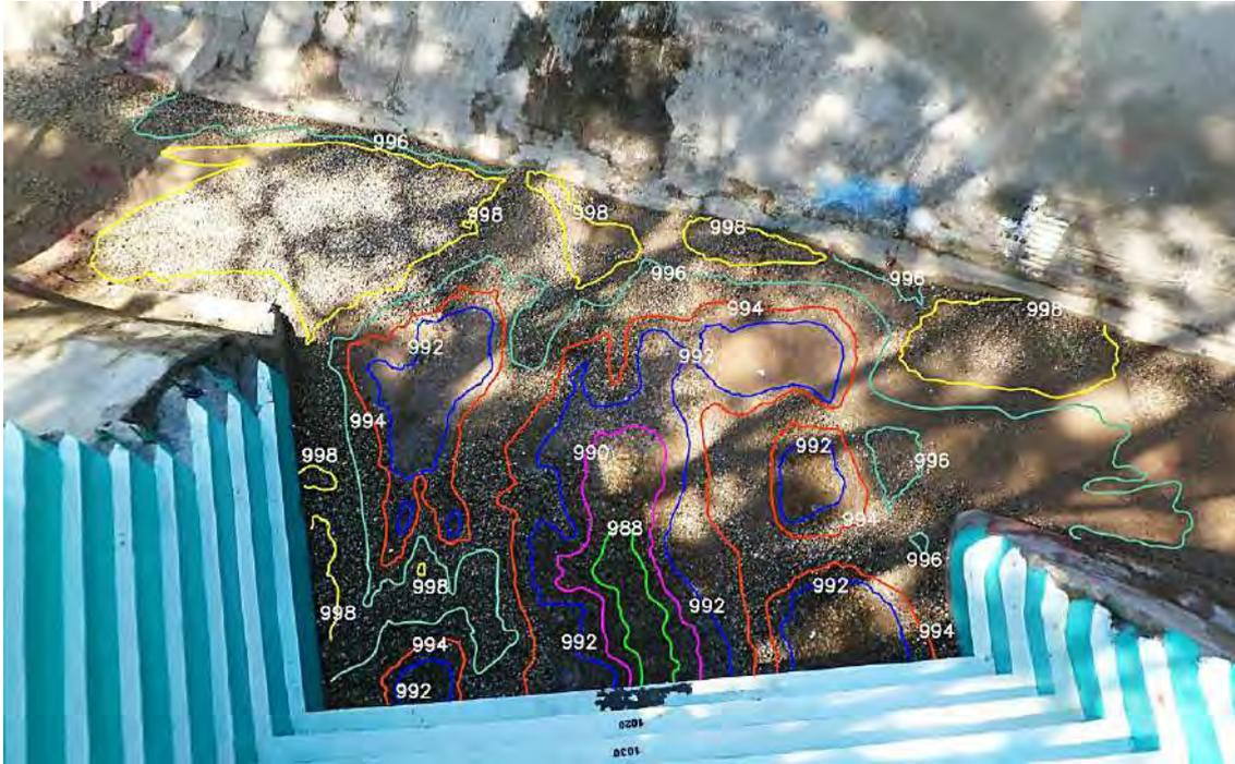
Figura 68. Curvas de nivel de la poza disipadora erosionada –  $Q = 300 \text{ m}^3/\text{s}$
