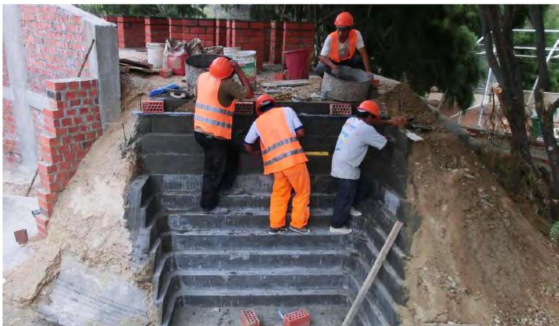
Figura 105. Construcción cuenco amortiguador a la salida de los vertederos.
