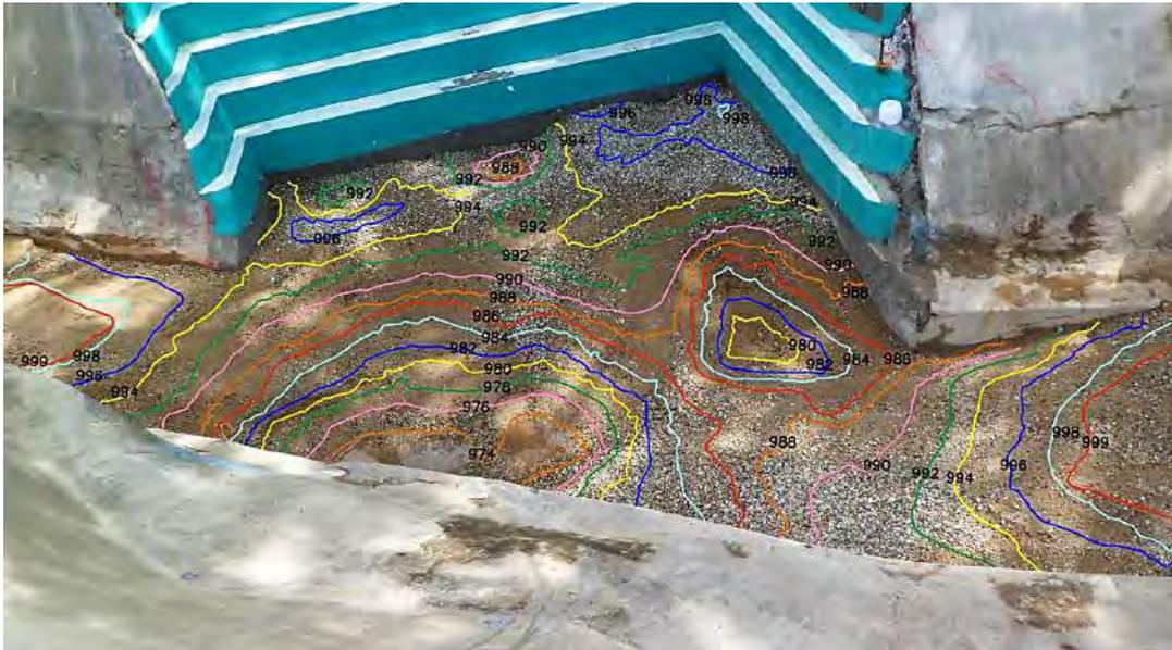
Figura 74. Curvas de nivel de la poza disipadora erosionada –  $Q = 1276 \text{ m}^3/\text{s}$
