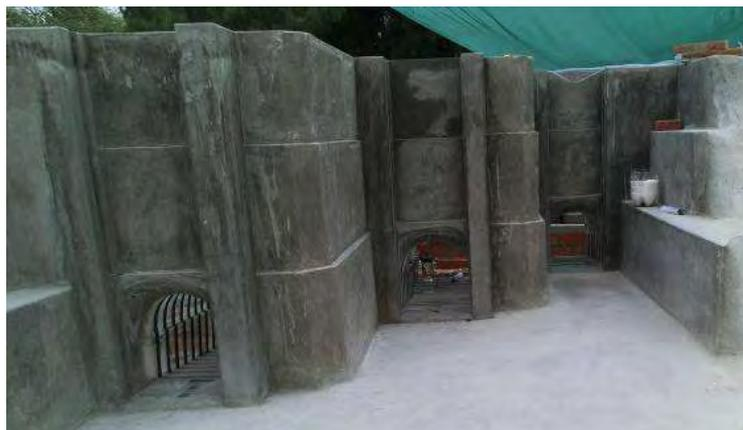
Figura 101. Detalle de la toma de vertedero en los 3 túneles
