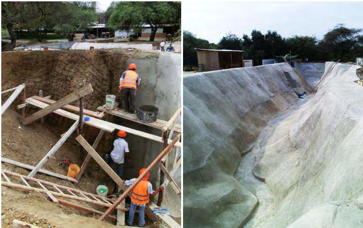
Figura 89. Perfilado de las márgenes del cauce de aproximación
