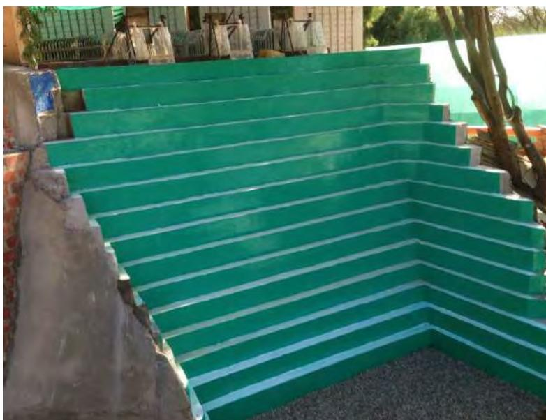
Figura 64. Disposición de las nuevas gradas y colocación de sedimentos en poza disipadora
