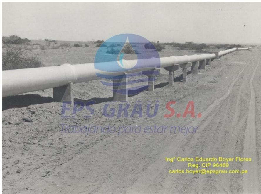
Figura N° H02-4: Tubería de 600 mm instalada en el Eje El Arenal-Talara.
