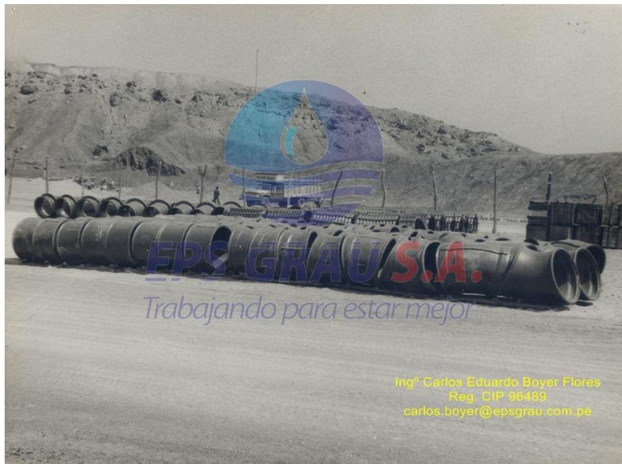
Figura N° H02-1: Accesorios de 600 mm a instalar en los Ejes El Arenal-Paita y El Arenal-Talara.
