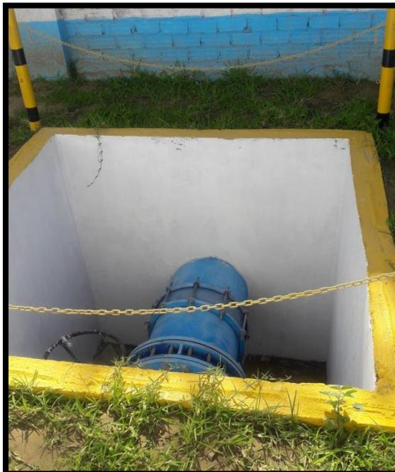
Figura N° A7: Ingreso de línea de conducción de agua tratada desde PTAP El Arenal a la cisterna.
