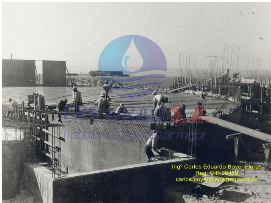
Figura N° H01-1: Predecantador de PTAP El Arenal en proceso de Construcción.
