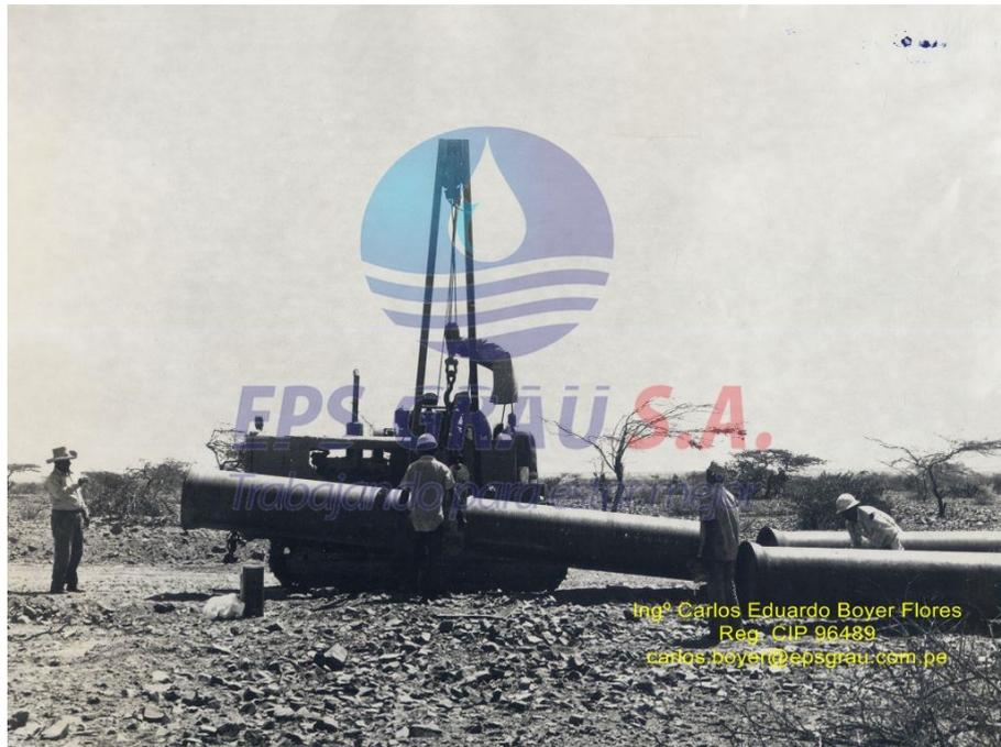
Figura N° H02-3: Proceso de instalación de tubería de 600 mm del eje El Arenal-Talara.
