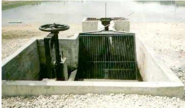
**Figura N°6: Rejillas Actuales de la Planta de Acopio Mejía**
