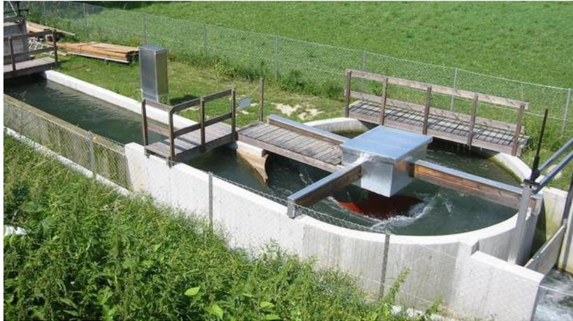
Figura 15. Micro central de vórtice gravitacional en Ober-Grafendorf.
