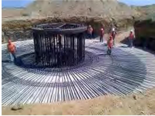
**Figura 18.** Anillos para cimentación de torres.
