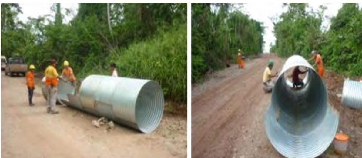
**Figura 3.19 : Armado de tuberías de TMC**
