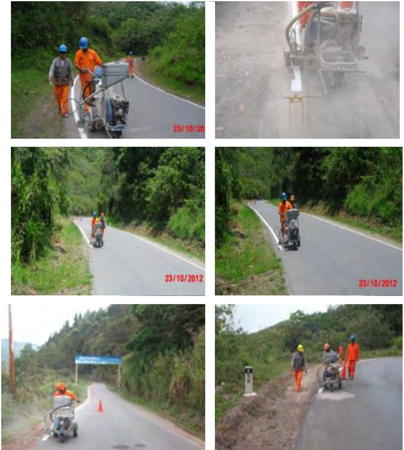
**Figura 3.22: Marcas en el pavimento**
