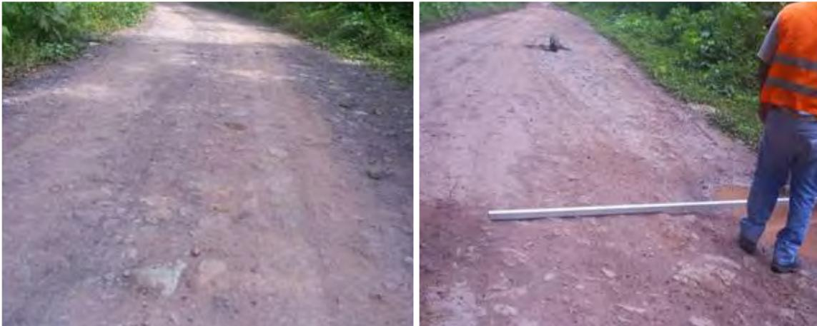
**Fig. 2.19: Progresiva km.92+000 – km. 93+500. Plataforma en mal estado con baches profundos y empozamiento de aguas**
