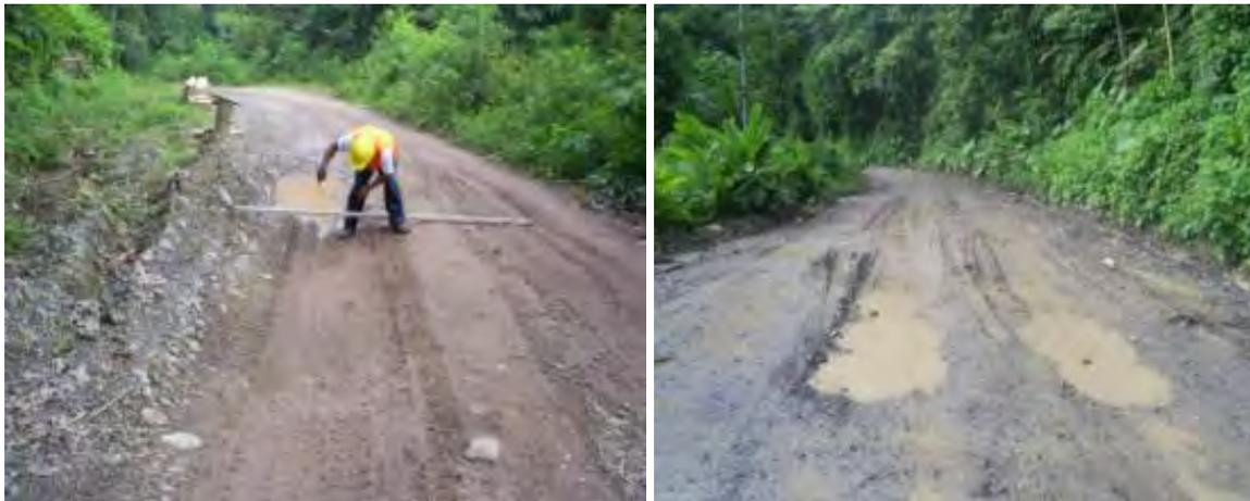
**Fig. 2.23: Plataforma en mal estado, con baches profundos y empozamiento de aguas**
