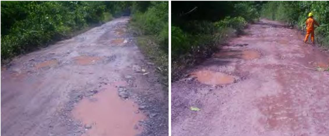
**Fig. 2.16: Progresiva km 89+500 - km. 90+500. Plataforma en mal estado con baches profundos y empozamiento de agua**
