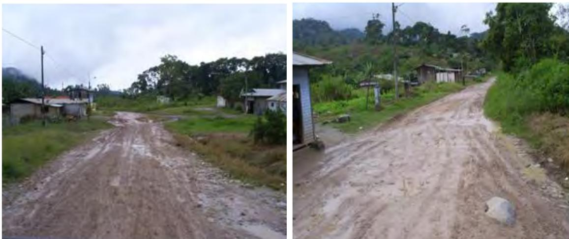
**Fig. 2.10: Progresiva km 50+500 – km 51+000 (eneñas): asentamiento de la plataforma**
