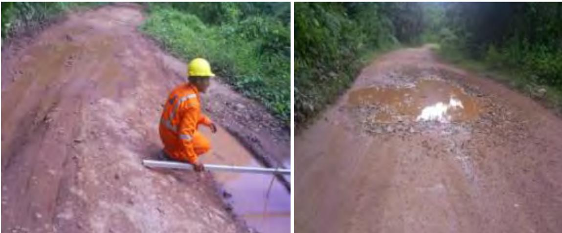
**Fig. 2.20: Progresiva km 93+500 – km 95+000. Plataforma en mal estado, con baches profundos y empozamientos de aguas**
