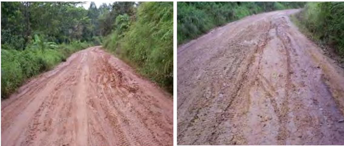
**Fig. 2.9: Progresiva km 48+500 – km 49+000: asentamiento de la plataforma**
