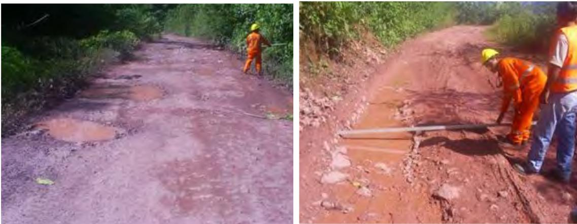
**Fig. 2.17: plataforma en mal estado con baches profundos y empozamiento de aguas**
