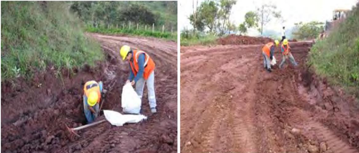
**Fig.2.11: Progresiva km 56+406 – km 56+466. Plataforma saturada y con asentamientos**
