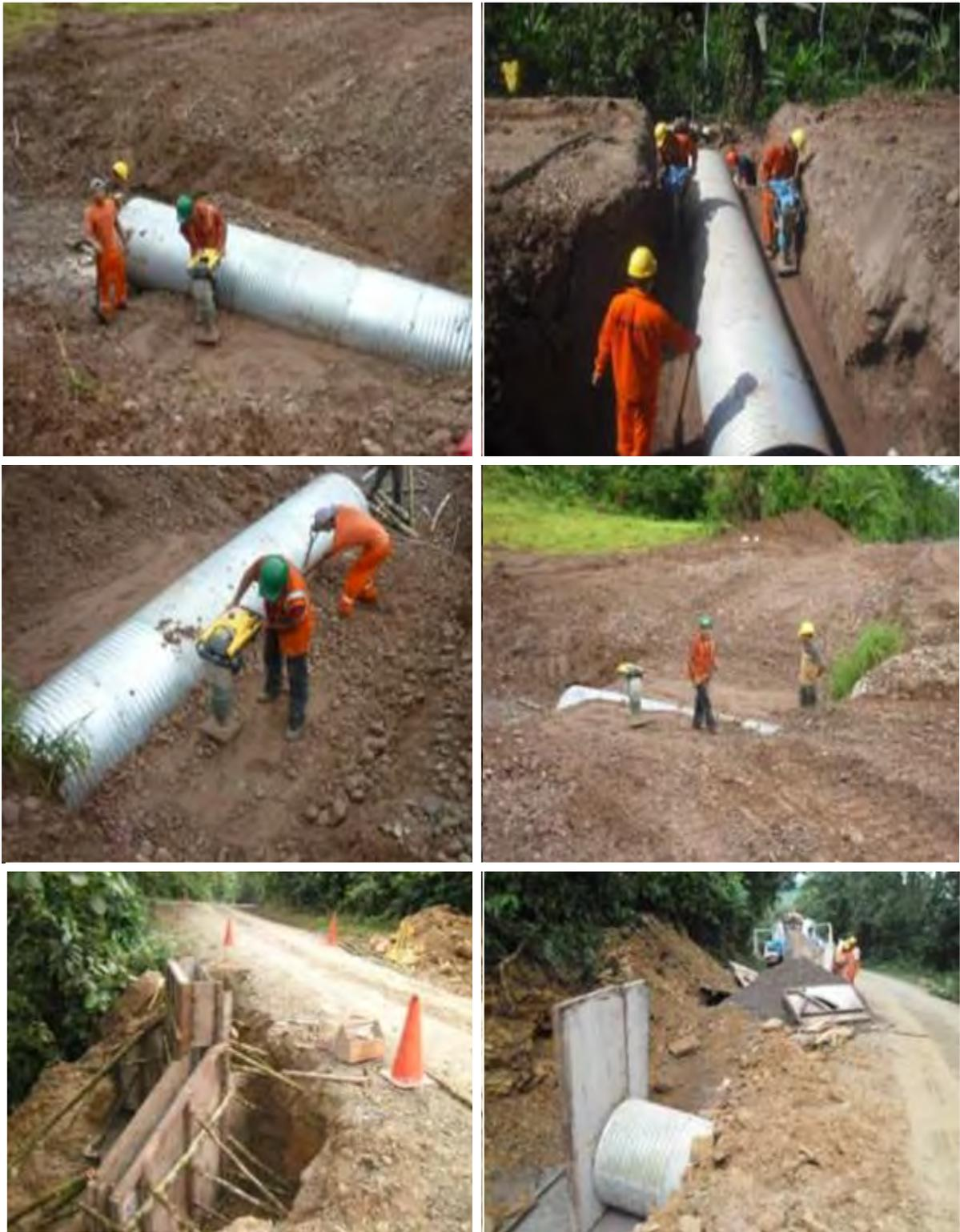
**Figura 3.20 : Colocación y relleno de tubería TMC**
