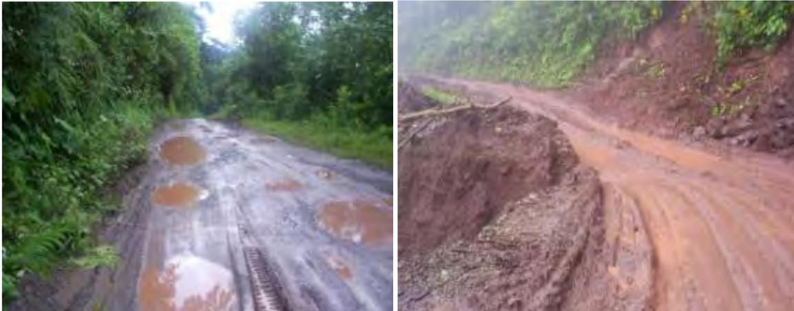
**Fig.2.26: Progresiva km 123+500 – km 125+500. Plataforma en mal estado con baches profundos y empozamiento de agua**
