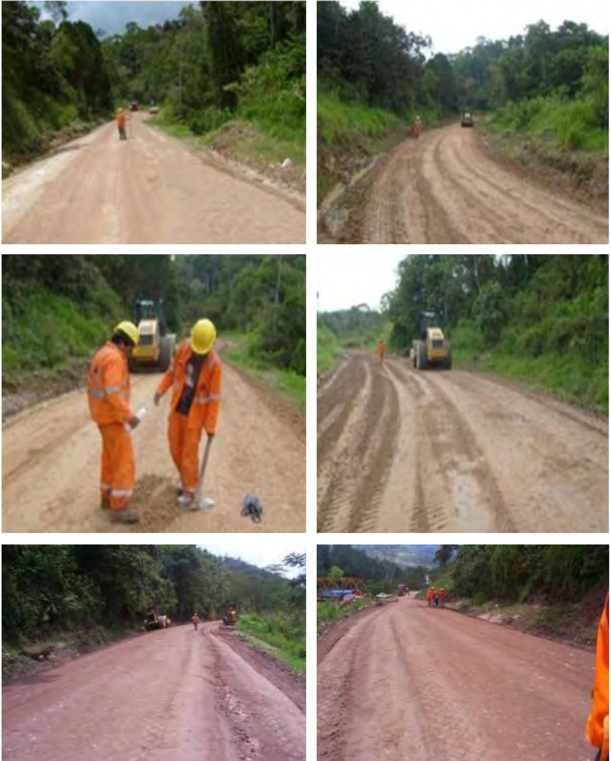
**Figura 3.14: Conformación y compactación de plataforma estabilizada.**
