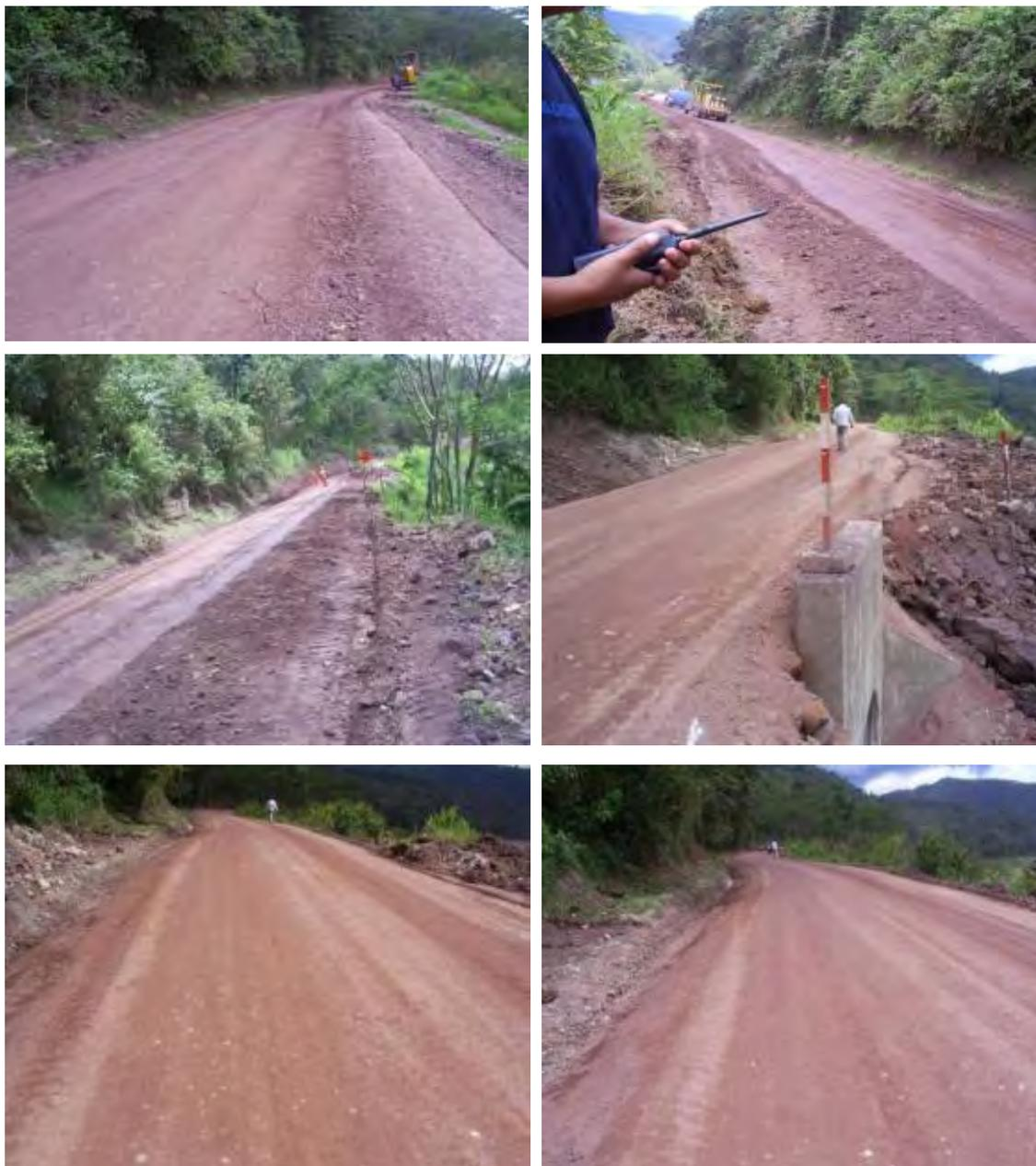
**Fig. 3.15 Conformación y compactación de plataforma estabilizada (continuación)**
