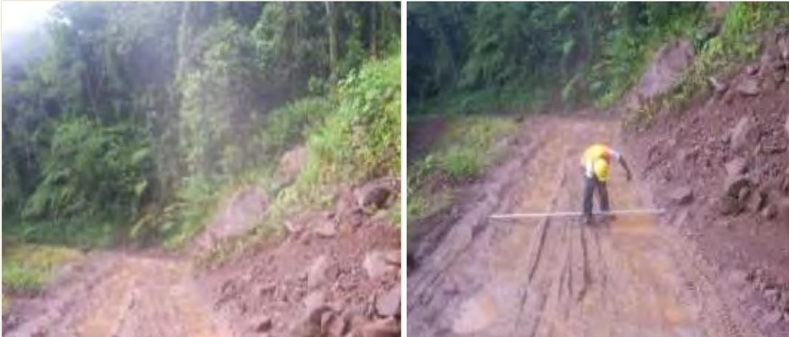
**Fig. 2.25: Progresiva km 119+700 – km 119+780. Plataforma en mal estado con baches profundos y empozamiento de aguas**
