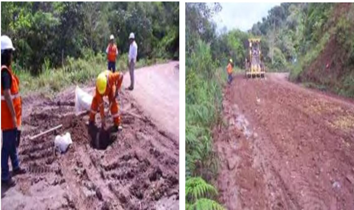
**Fig. 3.4: Verificación del suelo mediante una calicata**
