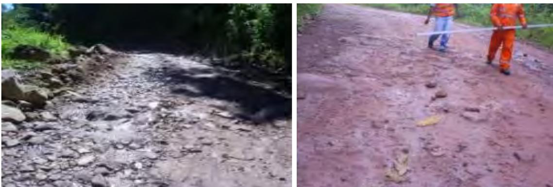
**Fig. 2.21: Progresiva km 95+000 – km 95+500. Plataforma en mal estado con baches profundos y empozamientos de aguas**
