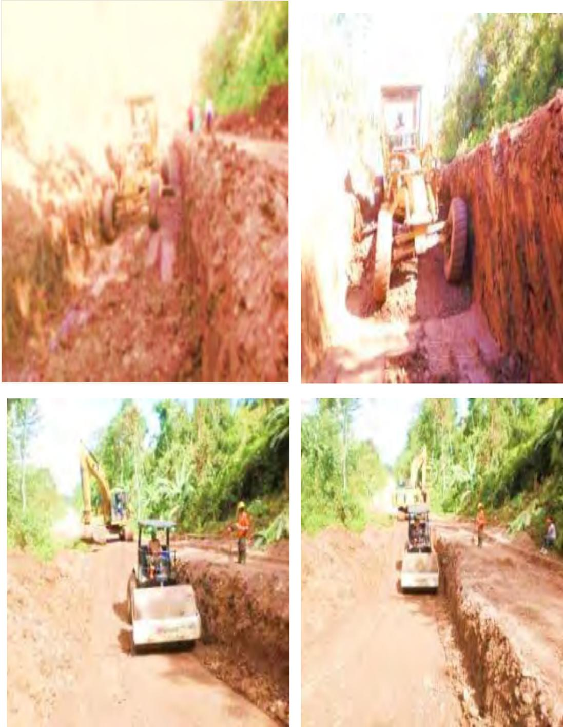
**Fig. 3.3 Acondicionamiento, conformación y compactación de material de Cantera de reemplazo**
