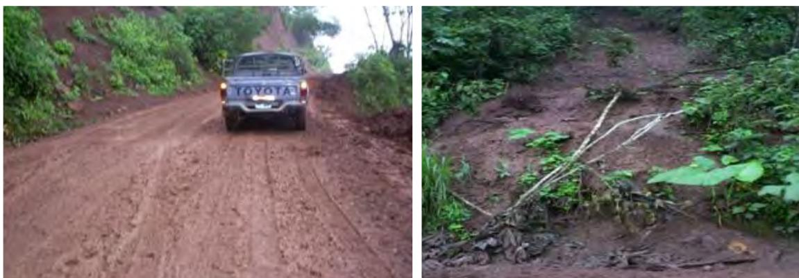
**Fig. 2.8: Progresiva km 44+606 – km 44+636: deslizamiento del talud superior izquierdo, con asentamiento y saturación de plataforma.**
