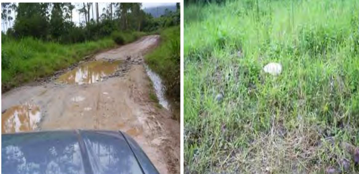
**Fig. 2.12: Progresiva km 49+050 – km 49+100. Plataforma saturada y depósitos de agua de filtraciones que dan origen a baches profundos**
