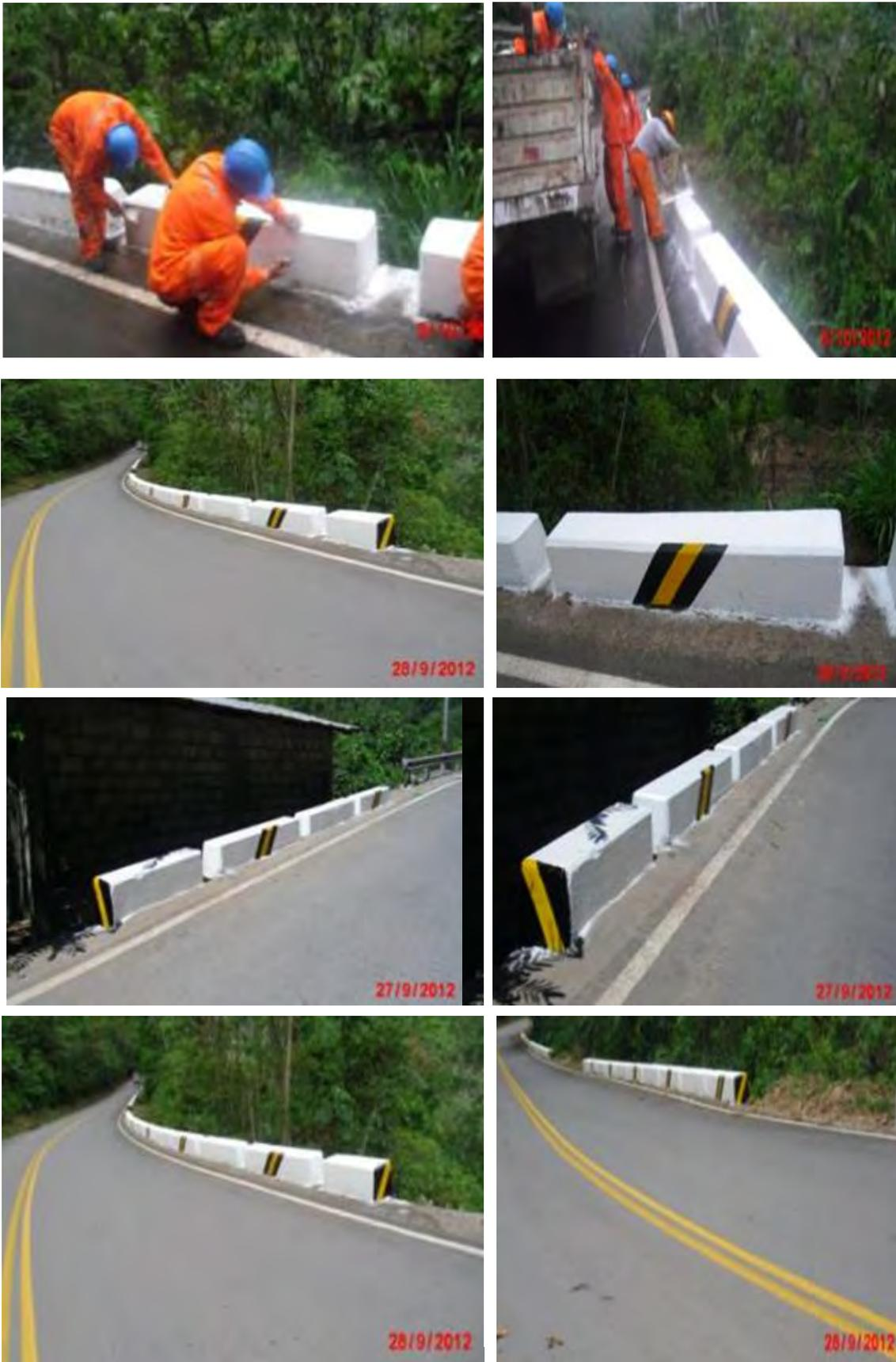
Fig. 3.24: Pintura de parapetos y muros
