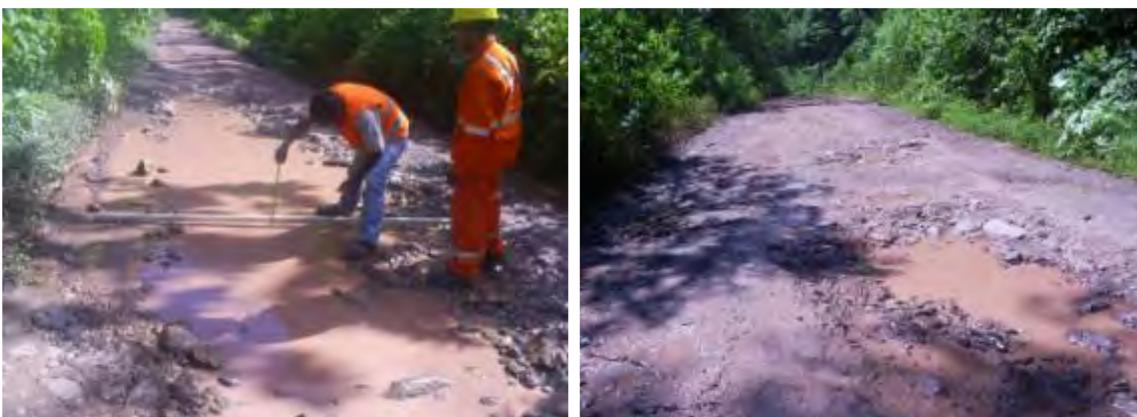
**Fig. 2.18: Progresiva km.90+500 – km. 92+000. Plataforma en mal estado, con baches profundos y empozamiento de aguas**
