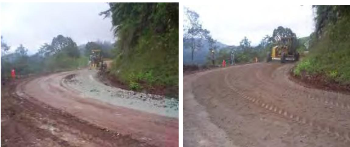
**Fig. 3.7 Proceso de colocación de aditivo y homogenización con recicladora**
