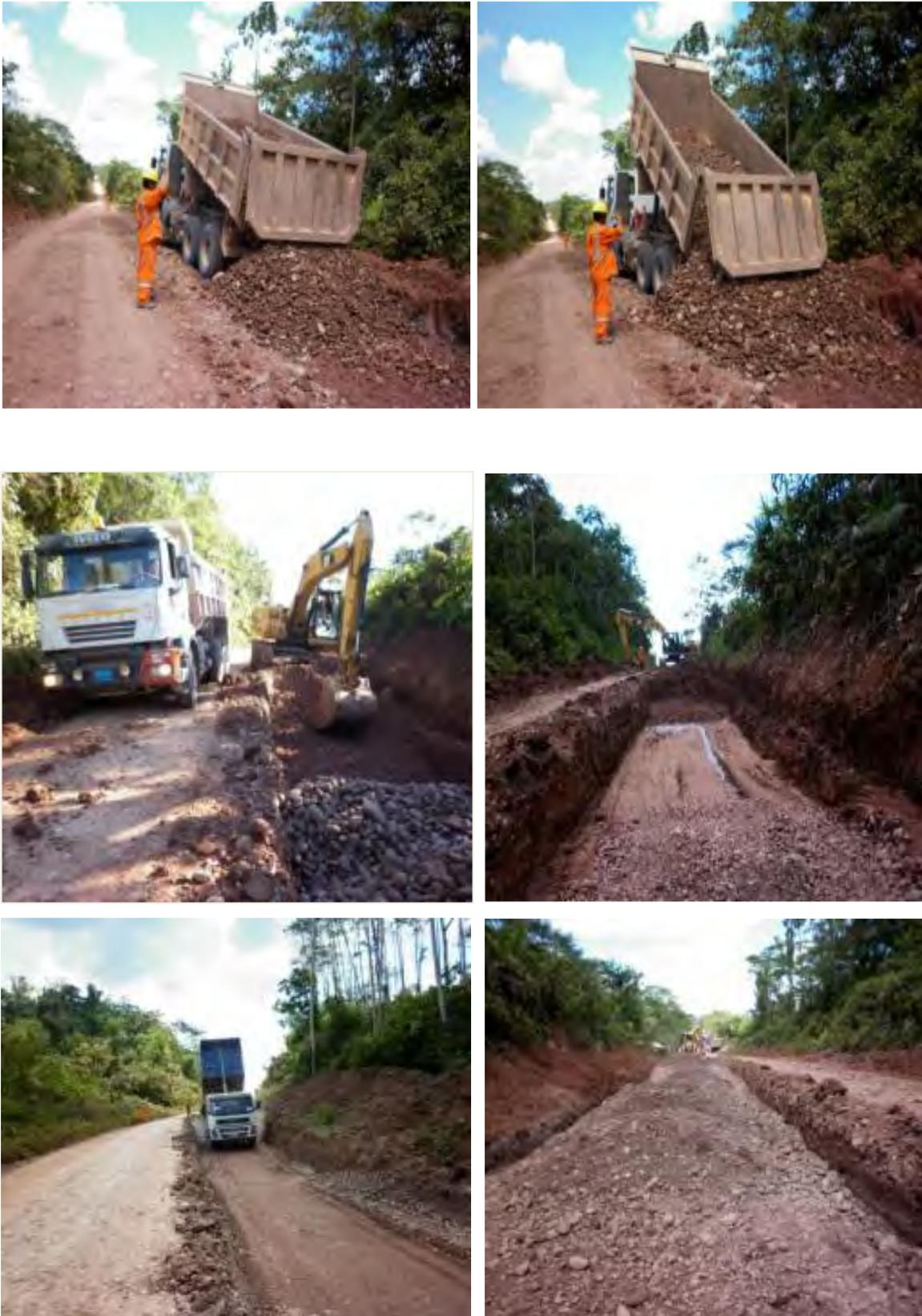
**Fig. 3.2: Transporte y colocación de material de cantera de reemplazo**
