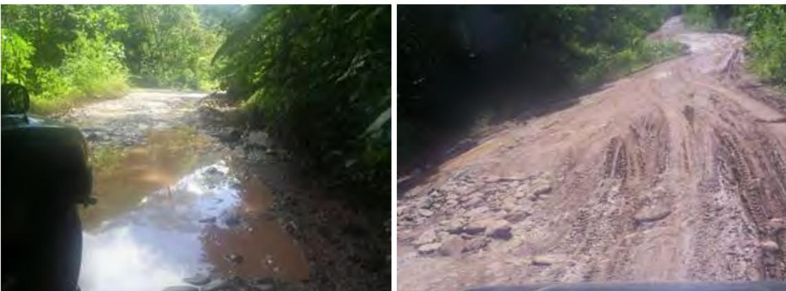
**Fig. 2.15: Plataforma en mal estado, con baches profundos y empozamientos de aguas**
