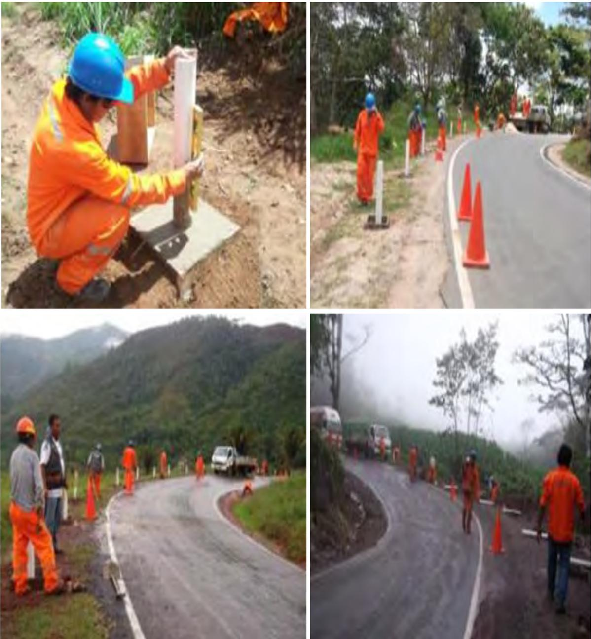
**Fig. 3.23: Instalación de delineadores**
