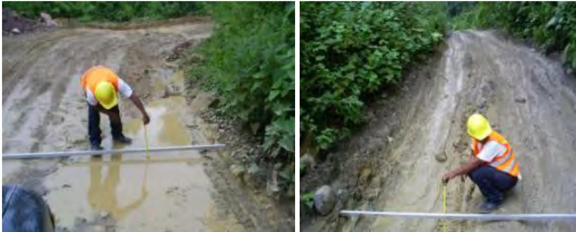
**Fig. 2.22: Progresiva km.114+500 – km. 115+500. Plataforma en mal estado, con baches profundos y empozamiento de aguas**
