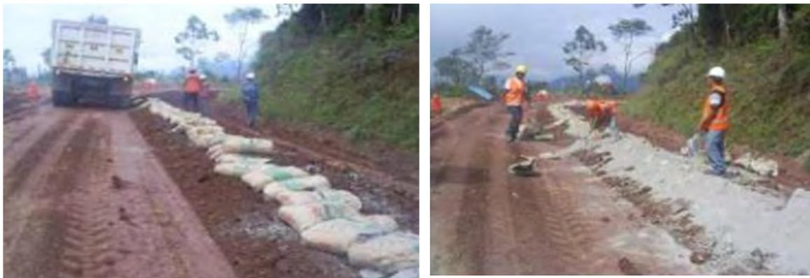
**Fig. 3.6 Proceso de colocación de aditivo y homogenización**
