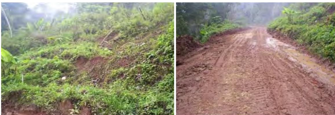
**Fig. 2.7: Progresiva km 44+360 – km 44+385. Deslizamiento del talud izquierdo de La carretera por filtraciones**
