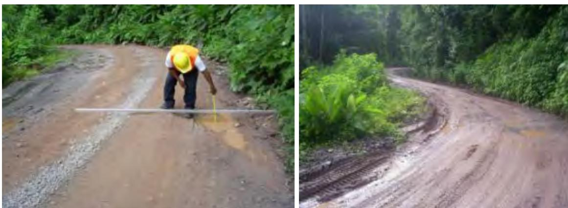
**Fig. 2.24: Progresiva km 115+500 – km 117+000. Plataforma en mal estado, con baches profundos y empozamiento de agua**
