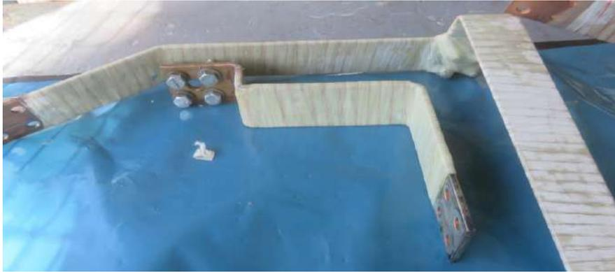
Figura 53. Nuevo aislamiento en barras de conexión
