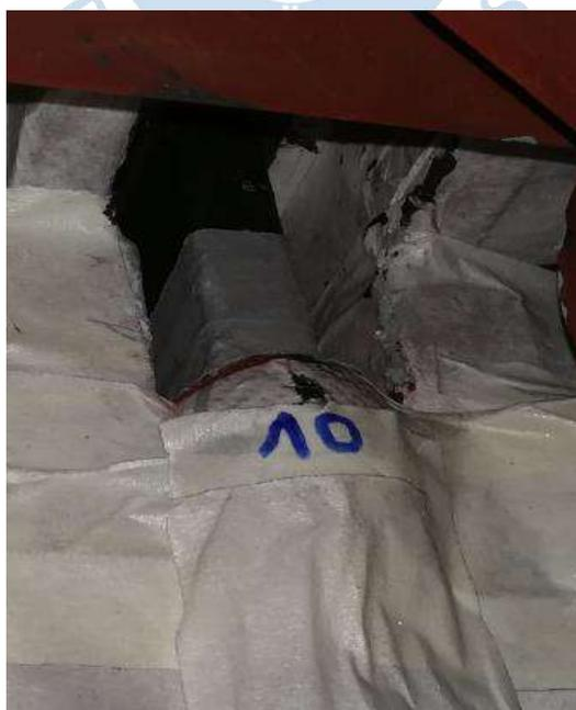
Figura 51. Curación en la bobina 10 por descargas parciales
