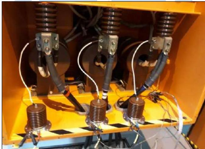
Figura 21. Acopladores instalados en la salida de fases.
