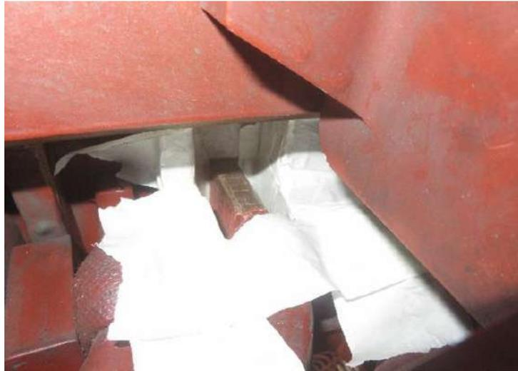
Figura 44. Descarga parcial en la bobina 10
