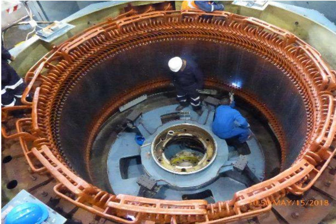
Figura 42. Estado inicial del estator
