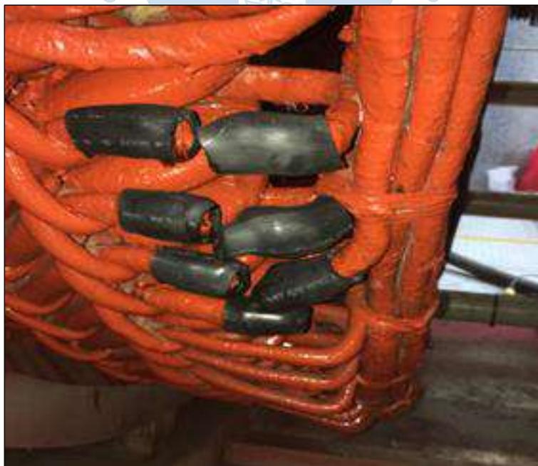
Figura 74. Manga termo contraíble en conexiones.
