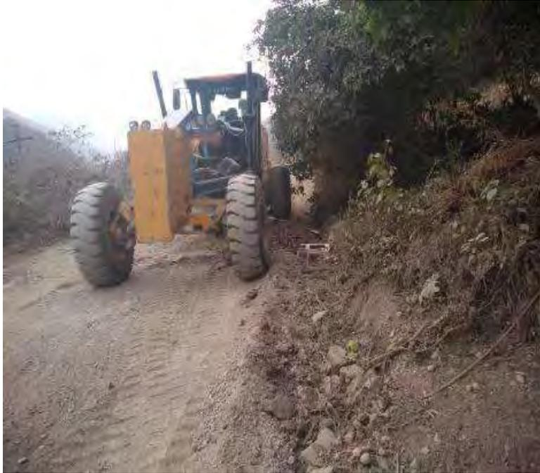
**Figura 6.** Reconformación de cunetas no revestidas
