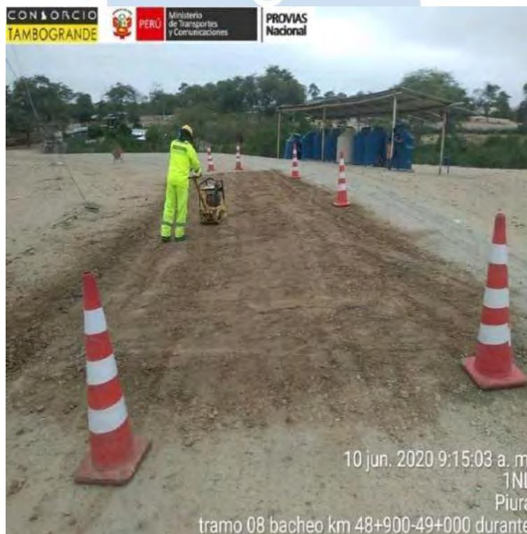
**Figura 5.** Bacheo en afirmado con equipo mecánico manual
