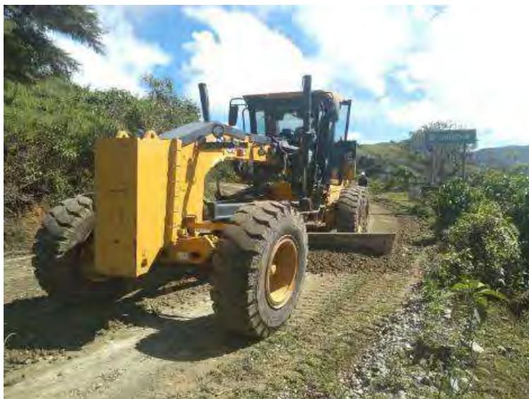
**Figura 3.** Perfilado de superficie sin aporte de material
