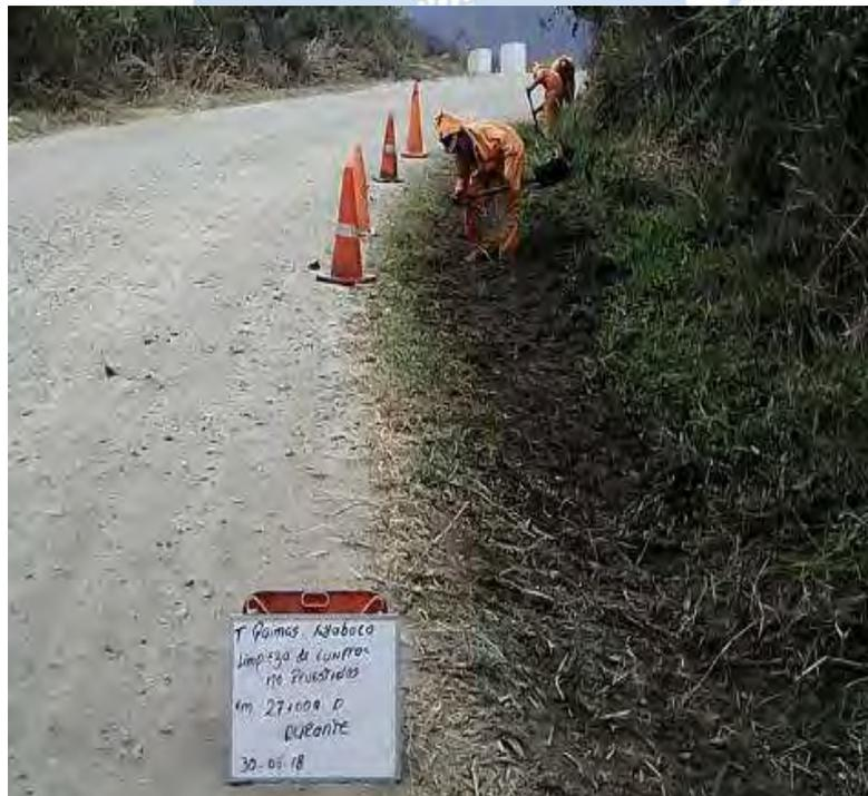
**Figura 7.** Limpieza y eliminación de basura en cunetas no revestidas
