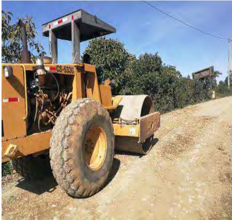
**Figura 4.** Bacheo en afirmado con rodillo liso vibratorio
