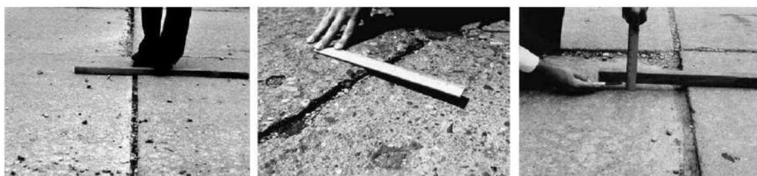
**Figura 13.** De izquierda a derecha, falla por escalonamiento de baja, media y alta severidad.
