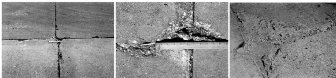
**Figura 25.** De izquierda a derecha, descascaramiento de esquina de baja, media y alta severidad.
