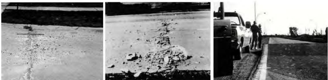
**Figura 10.** De izquierda a derecha, pandeo de baja, media y alta severidad. Fuente: ASTM D6433-03.
