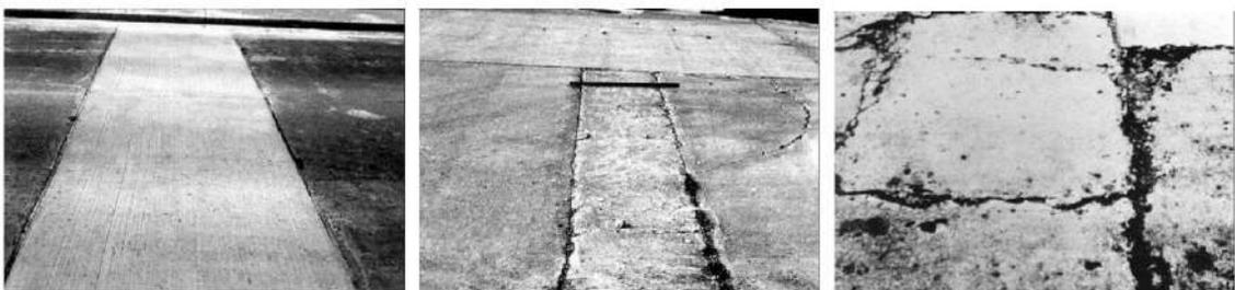
**Figura 17.** De izquierda a derecha, parcheo grande de baja, media y alta severidad.
