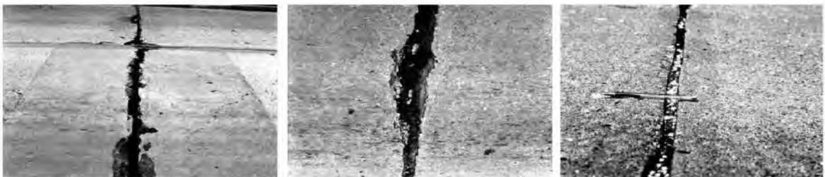
**Figura 14.** De izquierda a derecha, deterioro de junta de baja, media y alta severidad.
