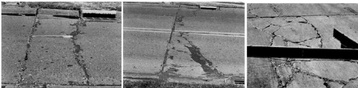
**Figura 22.** De izquierda a derecha, falla por punzonamiento, de baja, media y alta severidad respectivamente.
