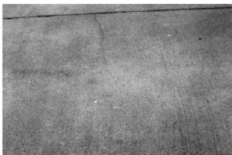
**Figura 24.** Fisuras de contracción. *Fuente: ASTM D6433-03.*
