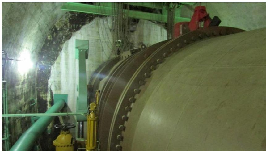
Figura 13. Salida de fondo del reservorio
