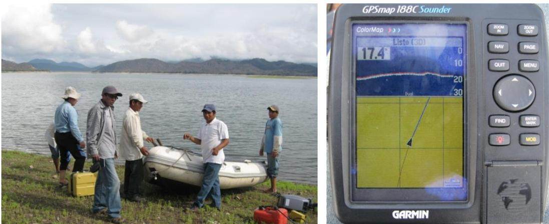
Figura 36. La figura que está ubicada a la izquierda, muestra el personal técnico y de apoyo, realizando los trabajos batimétricos en el Reservorio San Lorenzo, y la de la derecha, muestra el recorrido transversal de seccionamiento en el espejo de agua, registrado por la Ecosonda GPS Map 188C.
