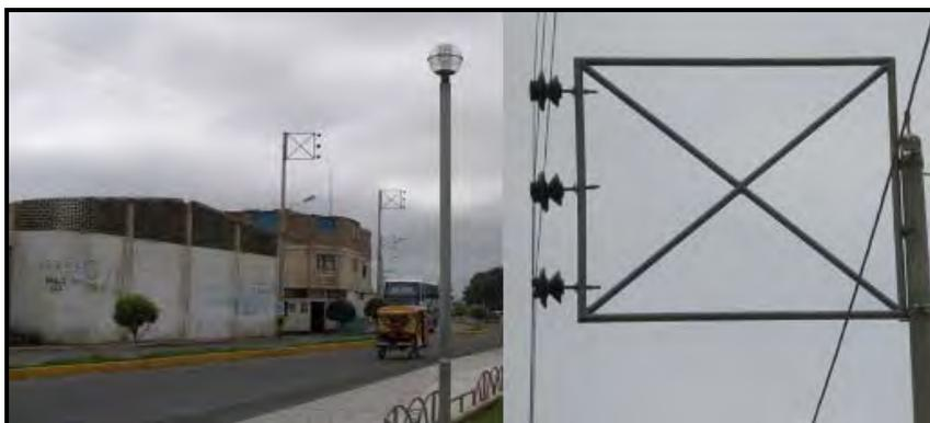
Foto 3.9. Posición pasante del conductor y los aisladores sujetos a los distanciadores
