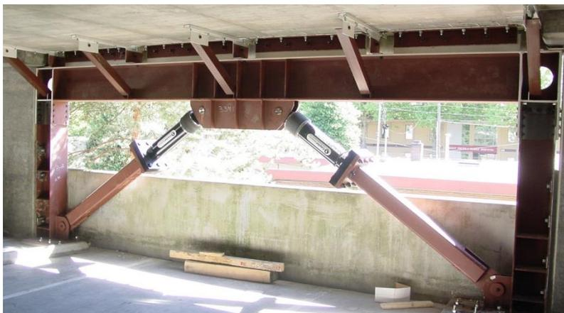
Figura A4. Amortiguadores en disposición Chevron. Fuente: Burgos M., 2012.
