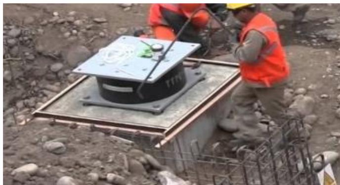
Figura 1.1. Instalación de aisladores en la construcción del Centro de Investigación FIC-UNI.
