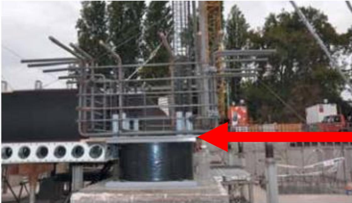
Figura A2. Instalación de un aislador en la base. Fuente: Seismic Protection Technologies, 2014.
