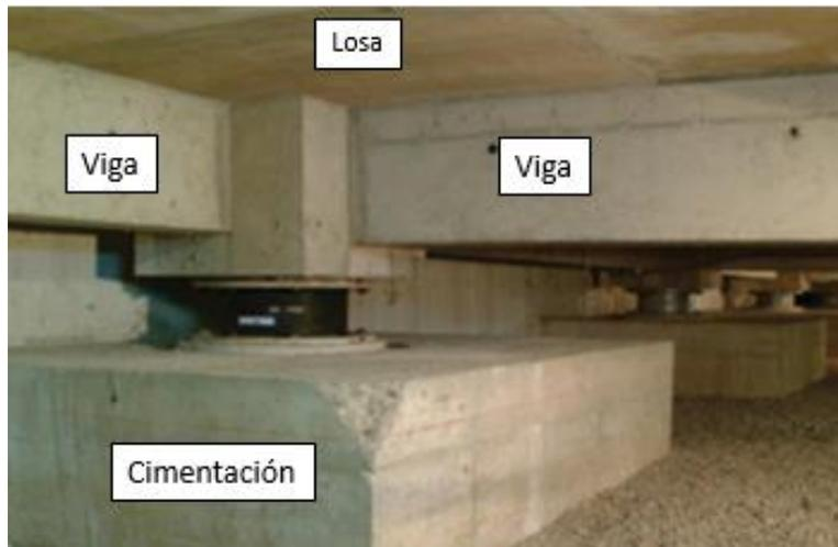
Figura 1.5. Sistema de aislación basal. Fuente: *Seismic Protection Technologies*, 2014.
