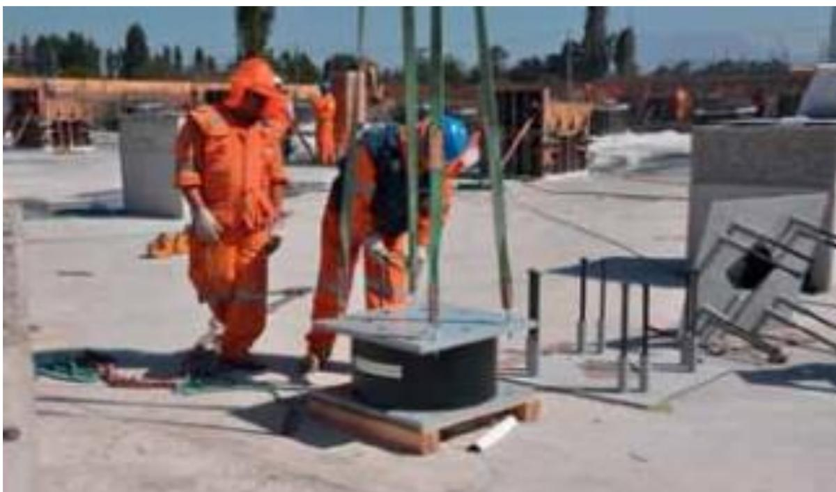
Figura A1. Instalación de un aislador en la base. Fuente: Seismic Protection Technologies, 2014.
