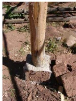
Se pueden pre fabricar bases de hormigón, dejando un agujero del diámetro del palo, para colocarlo y fijarlo dentro del suelo:
