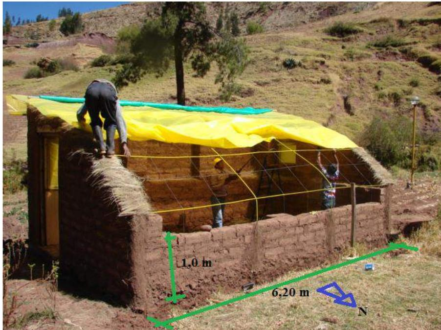
**Figura 47.** Invernadero tipo I, estructura techo, cubierta de P.E. 200 µm, pantalla externa antirradiativa de arpillera
