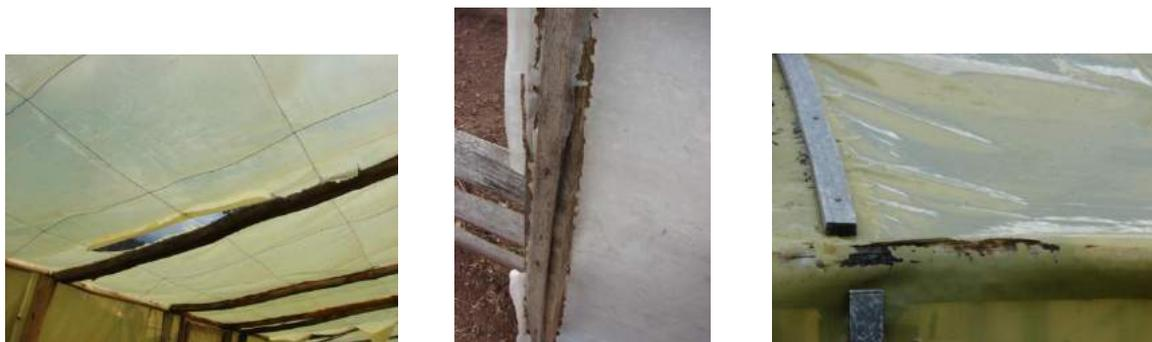
**Figura 56.** Deterioro del plástico en las uniones y contacto con la madera
