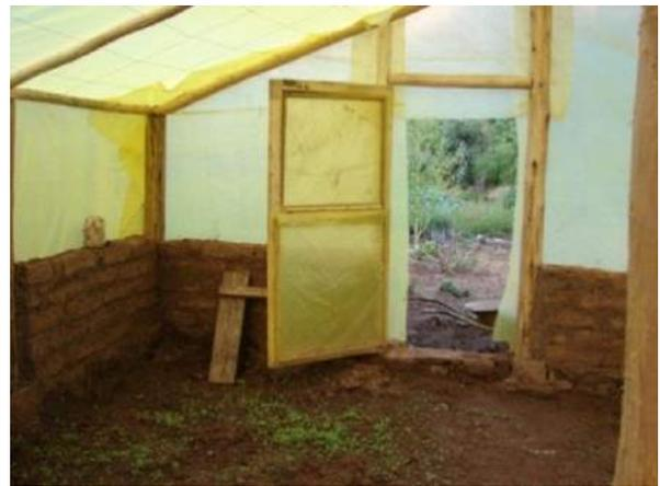
**Figura 52.** Puerta con ventana móvil en pared E
