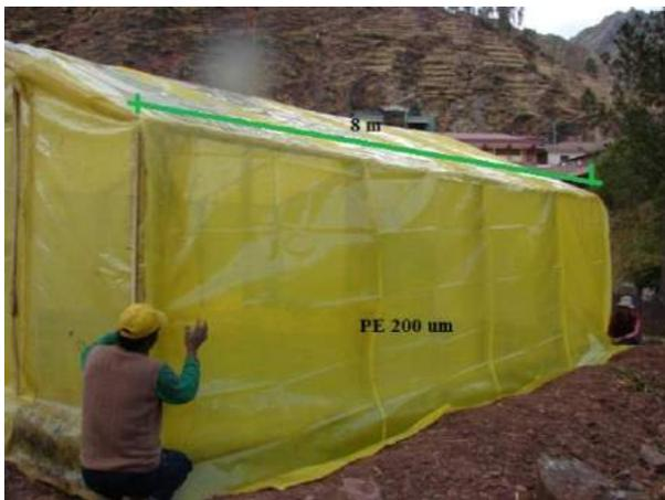
**Figura 51.** Pared lateral S, fijación de Plástico (enterrado en suelo)
