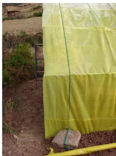
Fijación del plástico con soguilla bien tensada
