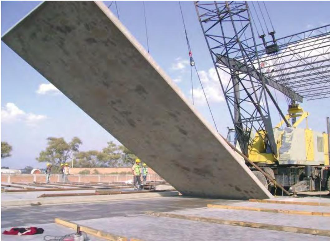
Figura 47: Izaje de placa prefabricada de concreto para construcción de edificación Tipo Tilt-Up.
