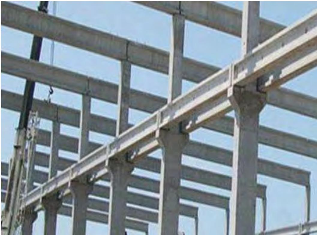
Figura 56: Estructura de concreto prefabricada en proceso de ensamble. Fuente: <http://guiamexico.com.mx/empresas/capesa-prefabricados-de-concreto.html>
