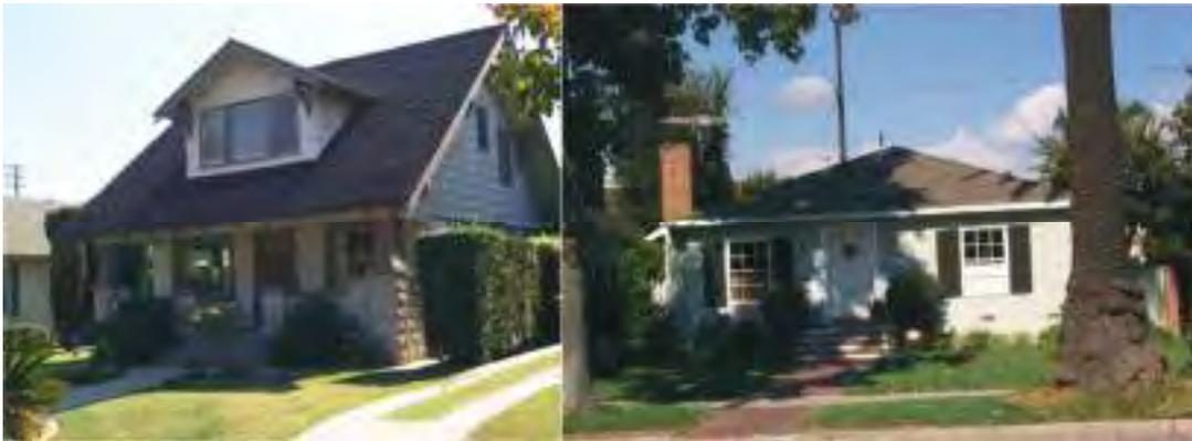
Figura 20: Estructuras de madera Tipo W1. Fuente: FEMA 154 (2002)
