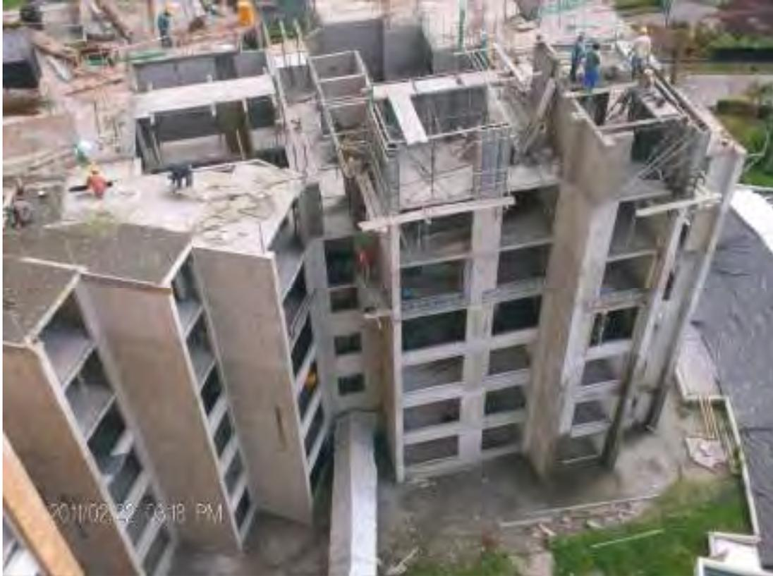
Figura 42: Estructura de pórtico de concreto con muros de corte de concreto en proceso de construcción. Fuente: <http://obrascivilesena7.blogspot.pe/>
