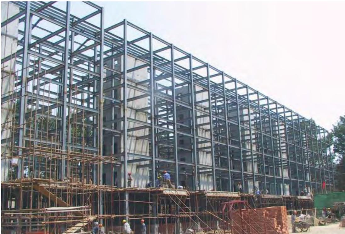
Figura 33: Ejemplo de estructura de acero con muros de corte de concreto en proceso de construcción. Fuente: <http://www.archiexpo.es/prod/union-living/product-148572-1655147.html>
