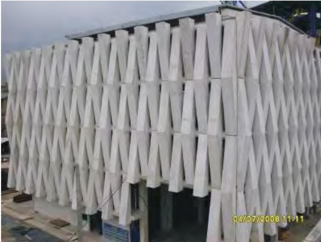
Figura 55: Estructura de concreto prefabricada. Fuente: <http://www.cpaprefabricados.com/>
