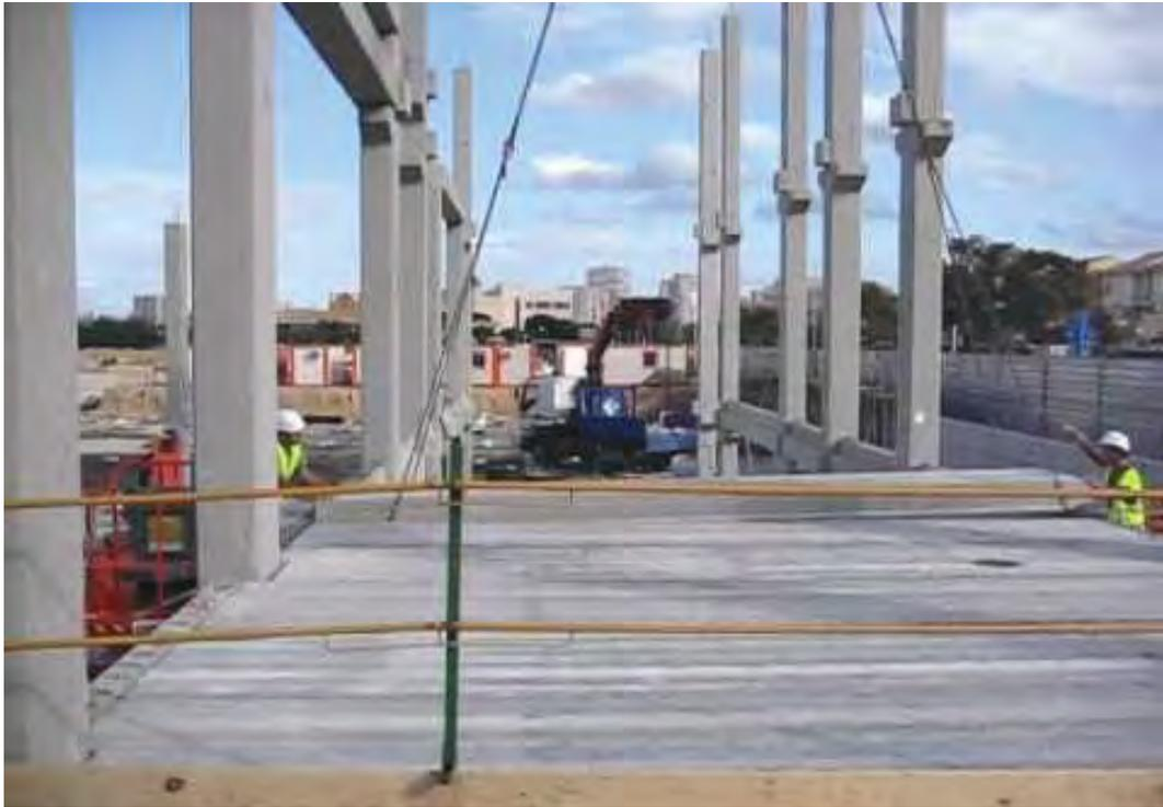
Figura 53: Estructura de concreto prefabricada en proceso de ensamble. Fuente: [https://www.youtube.com/watch?v=\\_HjyDYRrc1k](https://www.youtube.com/watch?v=_HjyDYRrc1k)
