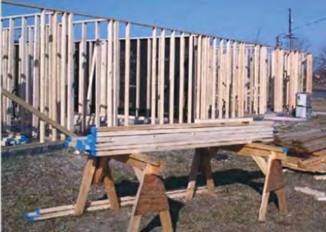
Figura 23: Detalle de armazón típica en estructuras de madera. Fuente: FEMA 154 (2002)
