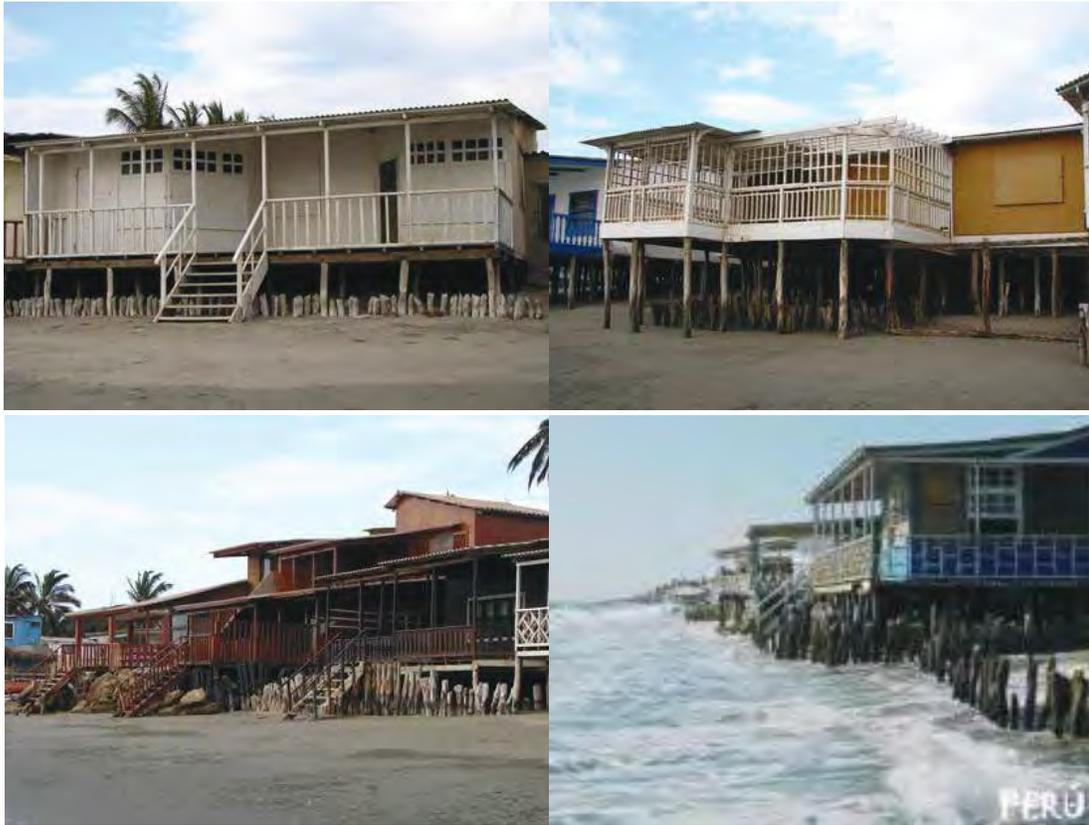
Figura 25: Ejemplo de estructura Tipo “Timber pole” emplazada cerca a la playa. Fuente: Elaboración propia.
