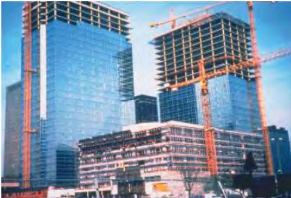
Figura 27: Estructura de acero tipo S1. Fuente: FEMA 154 (2002)
