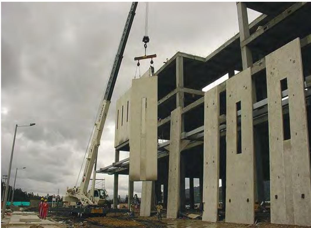
Figura 48: Izaje de placa prefabricada de concreto para construcción de edificación Tipo Tilt-Up.
