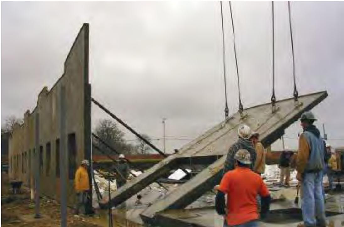
Figura 49: Izaje de placa prefabricada de concreto para construcción de edificación Tipo Tilt-Up.
