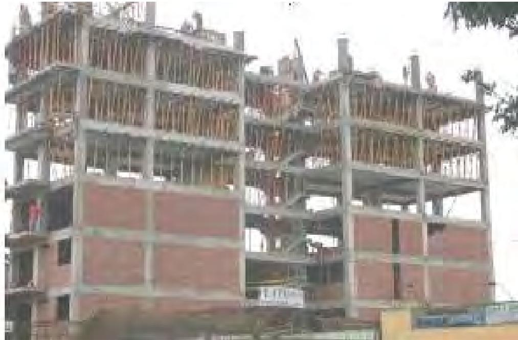
Figura 45: Ejemplo de pórticos de concreto con muro de albañilería no reforzado en construcción.
