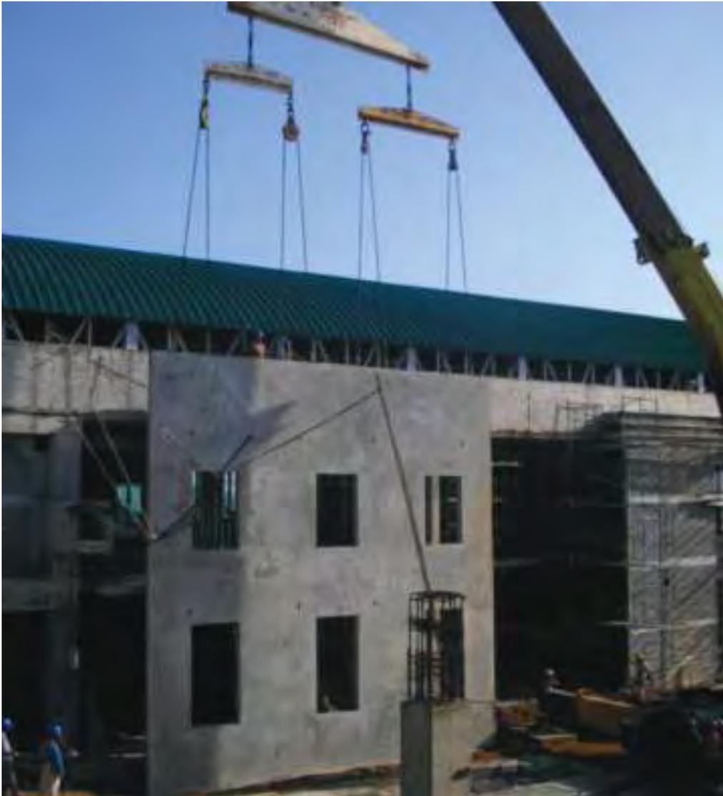
Figura 46: Izaje de placa de concreto prefabricada para construcción de edificación Tipo Tilt-Up.
