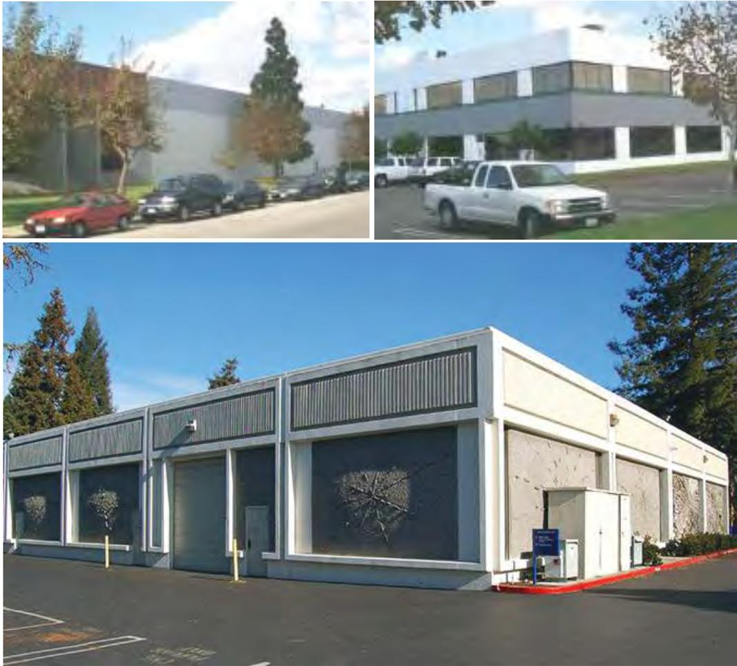
Figura 51: Edificaciones industriales tipo Tilt-up. Fuente: FEMA 154 (2002)
