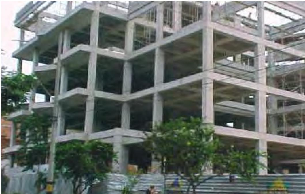
Figura 38: Edificación con pórticos de concreto en construcción. Fuente: <http://estructuras.eia.edu.co/estructurasI/conceptos%20fundamentales/conceptos%20fundamentales.html>
