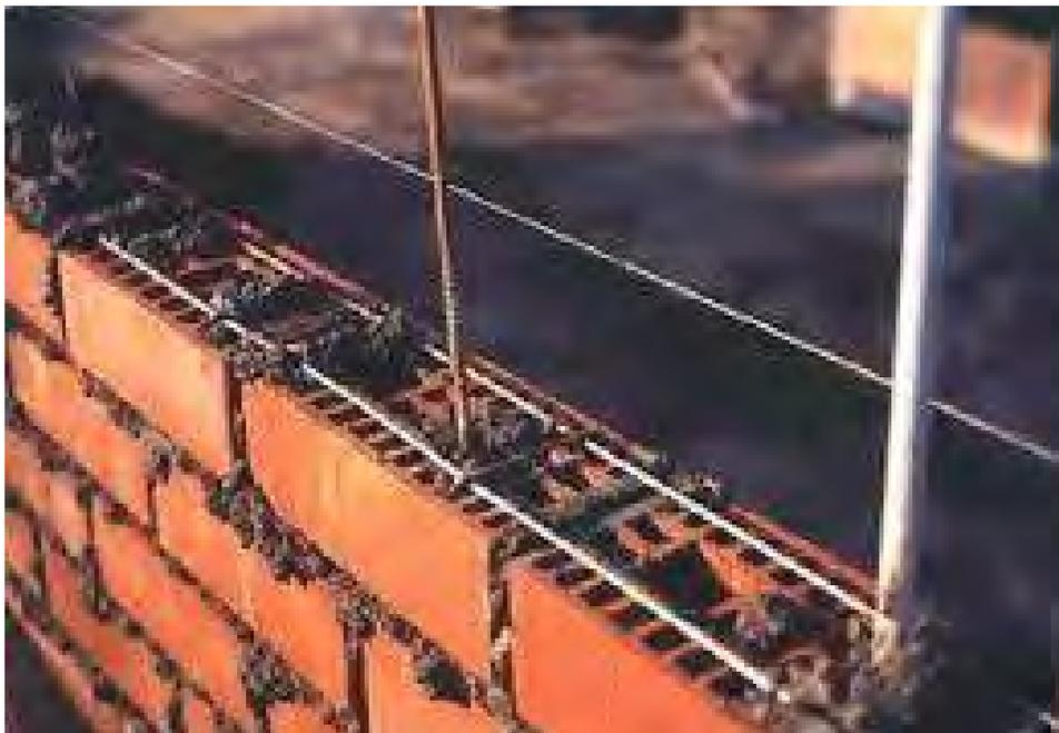
Figura 59: Acero de refuerzo en muros de albañilería. Fuente: <https://www.chilecubica.com/construcciones-en/alba%C3%B1iler%C3%ADa/>
