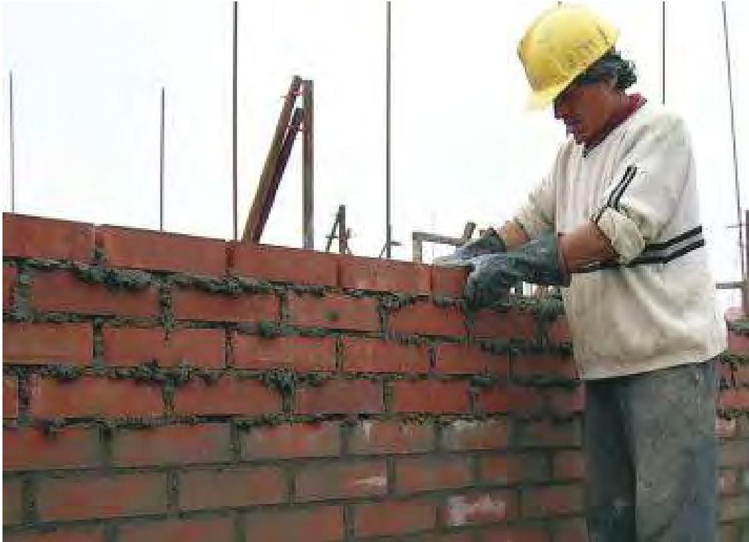
Figura 60: Levantamiento de muro de albañilería reforzada. Fuente: <http://www.ceramicasantiago.cl/user/productos/DSCN0323.JPG>
