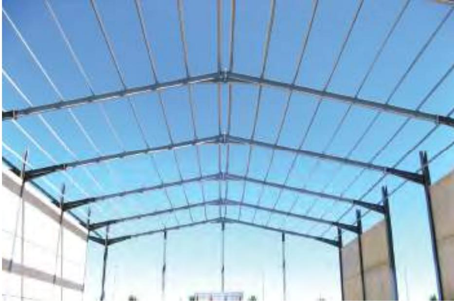
Figura 30: Vista interior de los pórticos transversales de una estructura de acero Tipo S3. Fuente: <http://www.patec.org/naves-prefabricadas-precios.php>
