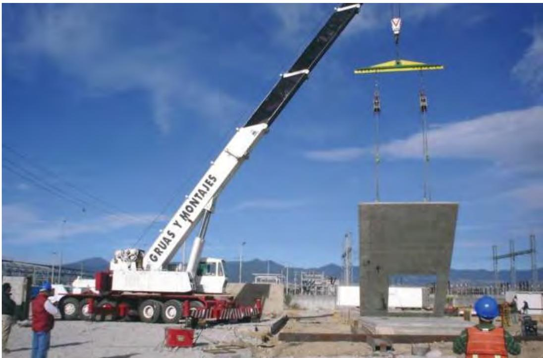
Figura 50: Izaje de placa prefabricada de concreto para construcción de edificación Tipo Tilt-Up.
