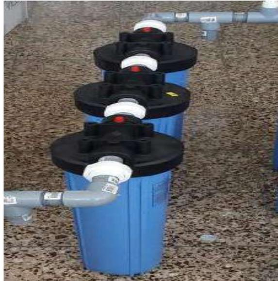
Figura 30. Filtros de 1  $\mu\text{m}$
