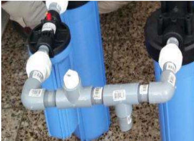
Figura 31. Instalación de accesorios
