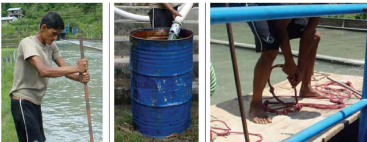
**Figura 105.** Medición del nivel de deposición de sedimentos, descarga y reubicación de la cabeza de succión.
