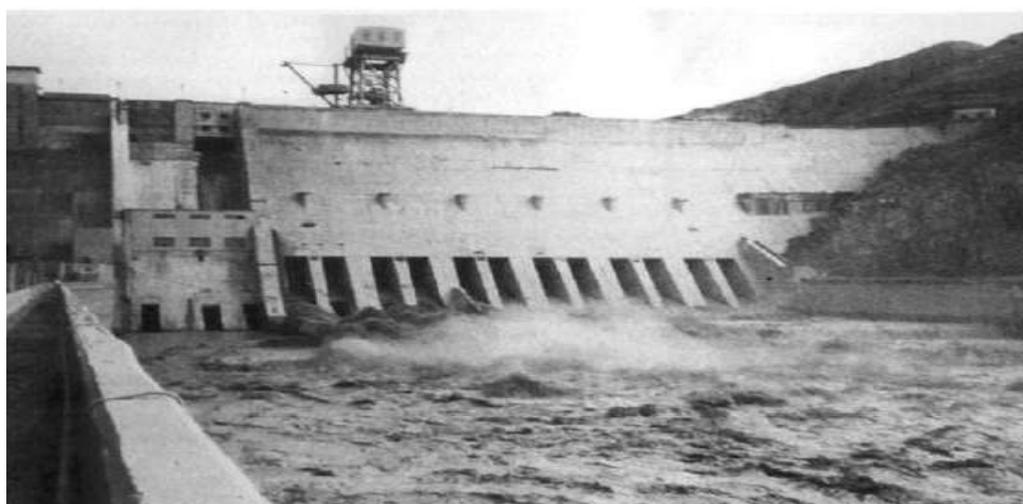
**Figura 67.** Aplicación del *flushing* en el embalse Sanmenxia, China.
