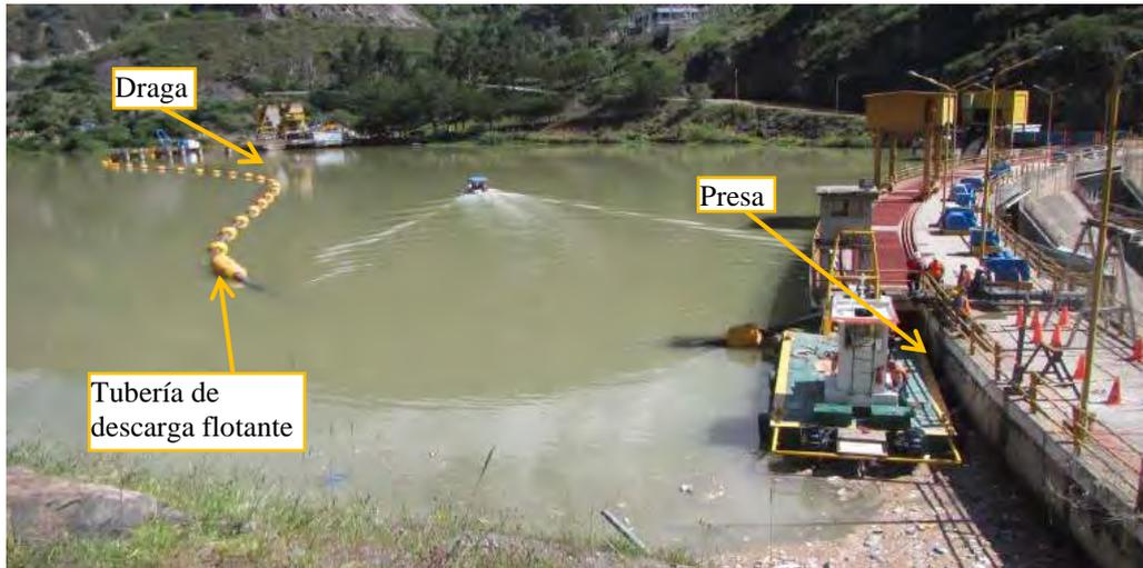
**Figura 90.** Vista del sistema de descarga de la draga sobre el embalse.
