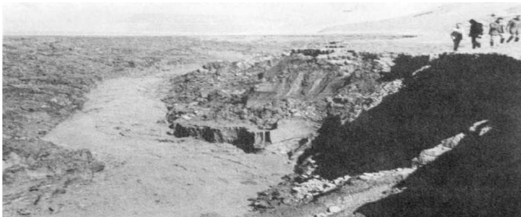
**Figura 64.** Orillas escarpadas de sedimento consolidado en el tramo medio del canal de desvío durante el periodo de erosión activa.
