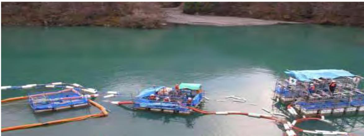
**Figura 82.** Tres barcazas para la operación de la cabeza de succión, el inyector de cámara de vacío y salida.
