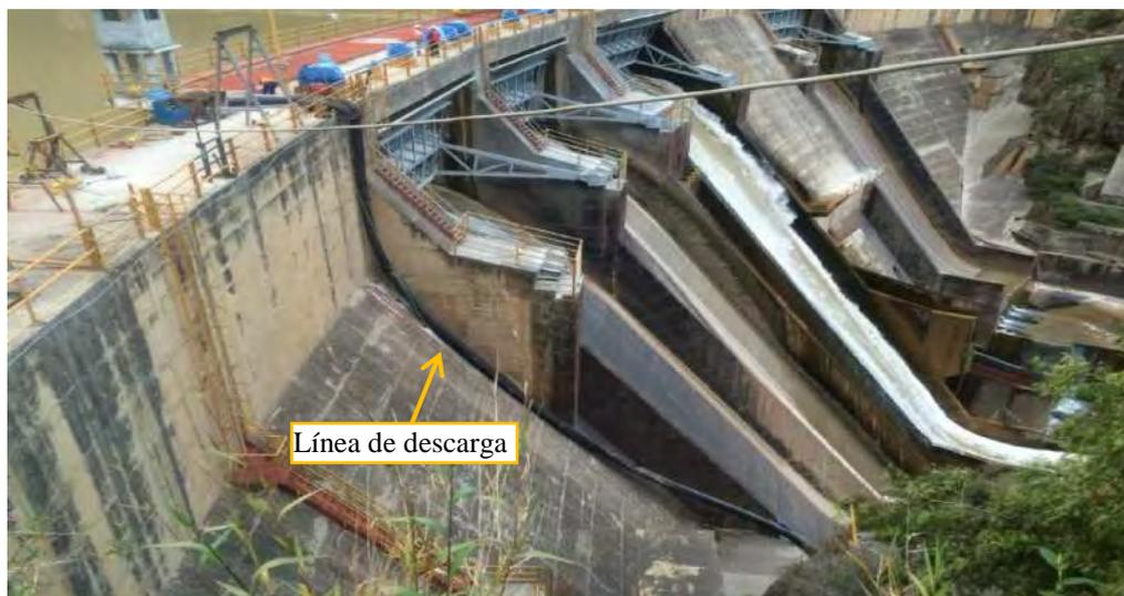
**Figura 92.** Vista del sistema de descarga sobre la presa.
