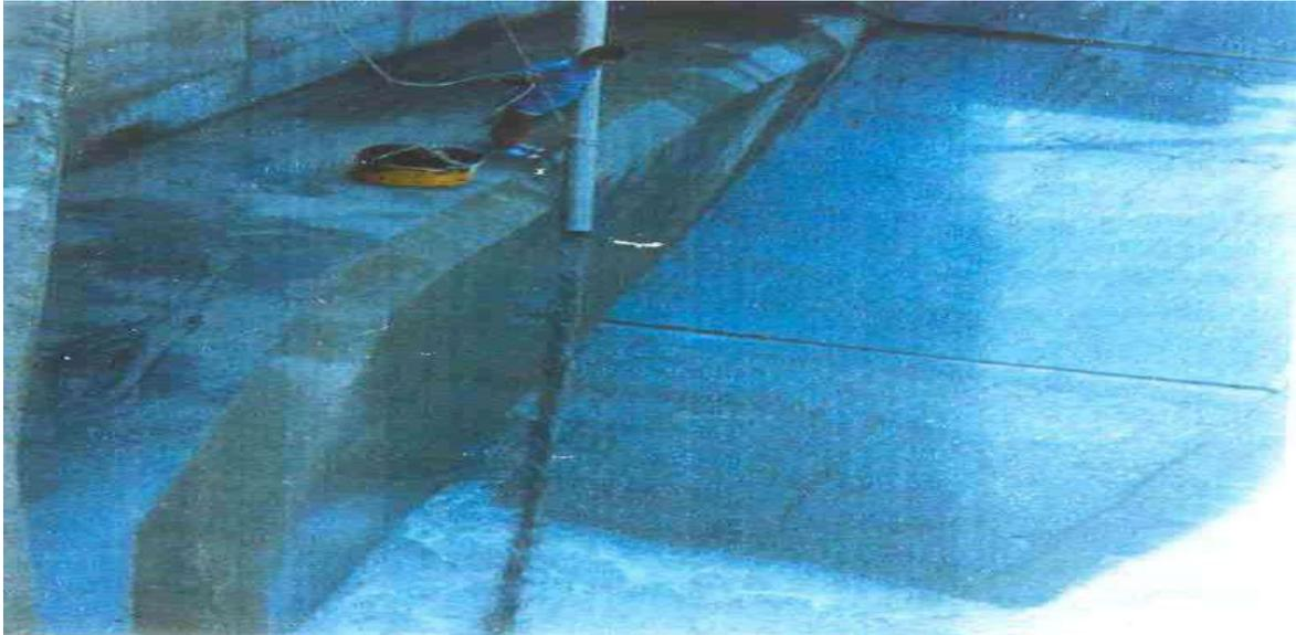
**Figura 97.** Sistema de hidrosucción de sedimentos en el embalse Cirato.
