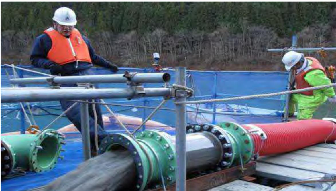
**Figura 84.** Descarga de sedimentos dentro de la trampa de limos.
