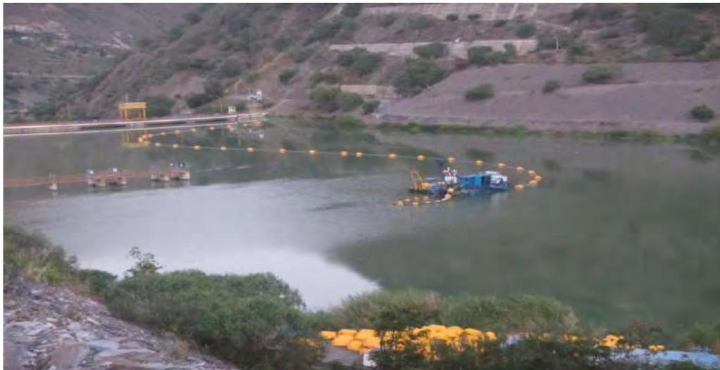
**Figura 91.** Vista panorámica de la draga y de la tubería flotante de descarga sobre el embalse.
