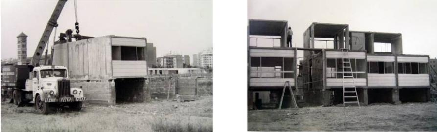
Fig.14. Diversos momentos del montaje.
