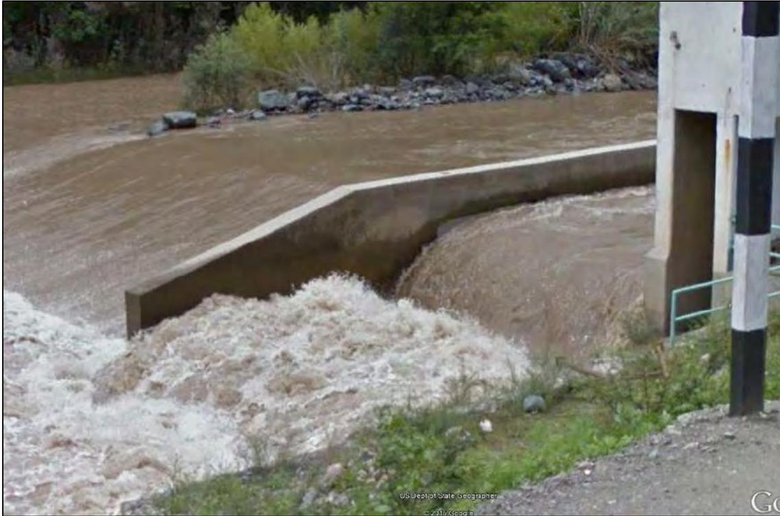
**Figura 4.128** Desbordamiento de agua en el aliviadero móvil con compuertas cerradas.
