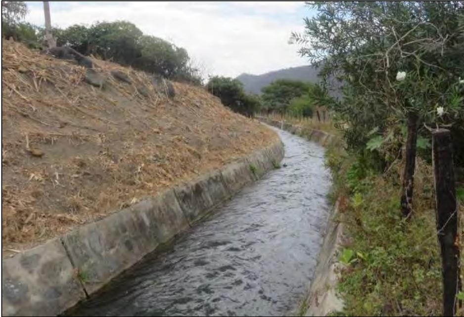
**Figura 2.26** Canal de aducción a la cámara de carga.
