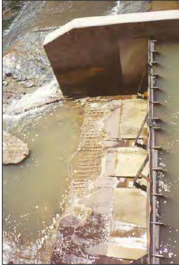
**Figura 2.27** Erosión en la placa de concreto Fondag.
