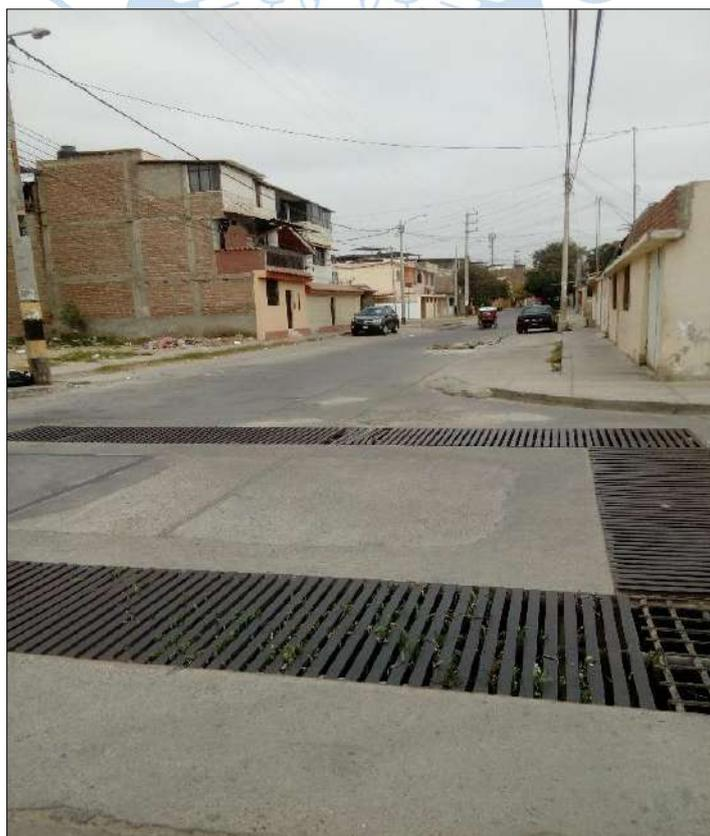
Figura 29. Rejillas transversales en el punto más bajo de la urbanización El Chilcal
