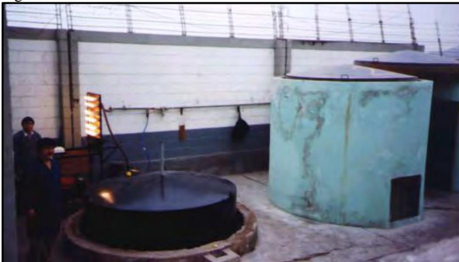
**Planta piloto de biogas de 10 m<sup>3</sup>, tipo Olade-Guatemala, con motogenerador de 1500 W.**
