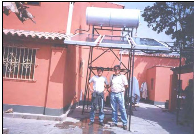
**Calentador solar de 500 Lts instalado por EDEVI en convento de Chaclacayo.**
