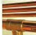
Hecho con tuberías de Cobre Rígido en toda la Red de Colectora
