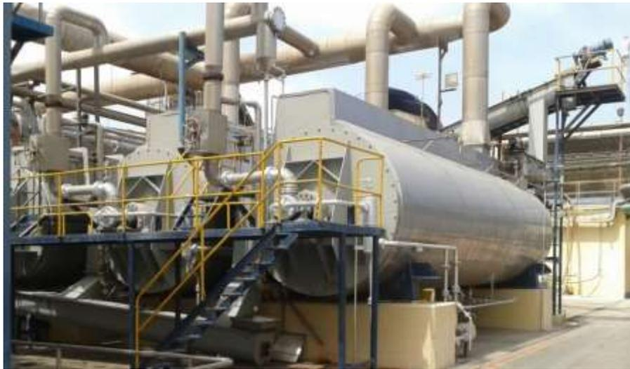
Figura 20. Secadores rotadiscos en paralelo
