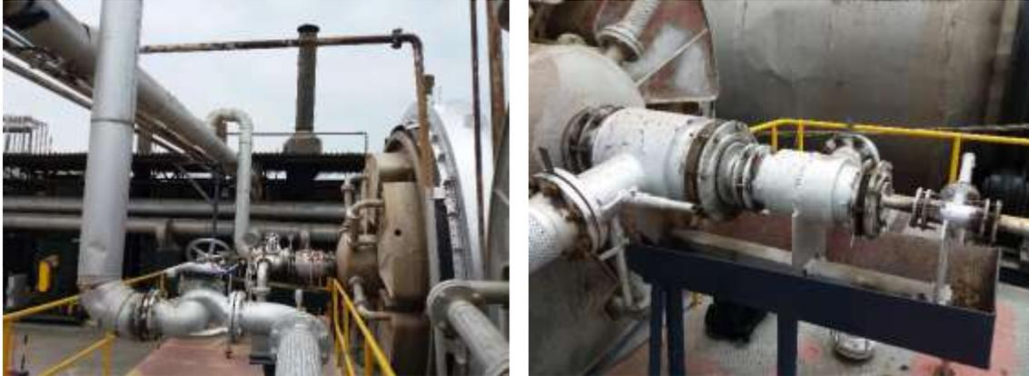
Figura 30. Suministro de vapor (izquierda) y descarga de condensado (derecha)
