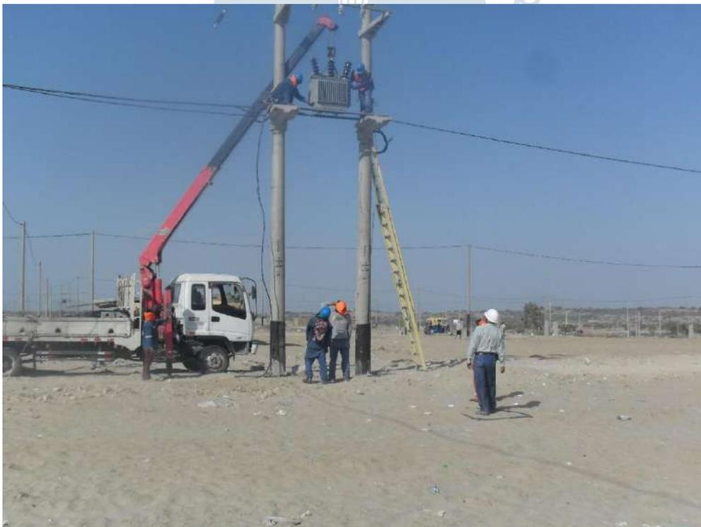
Figura 27. Montaje de transformadores
