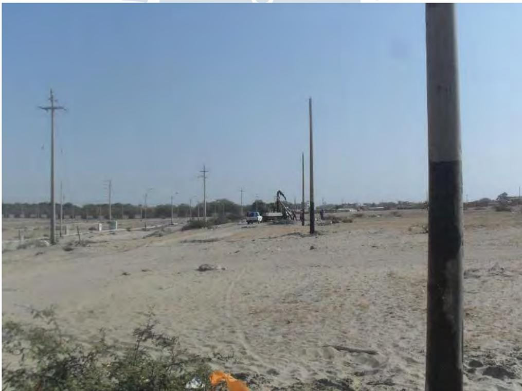
Figura 22. Izado de postes de alineamiento de baja tensión
