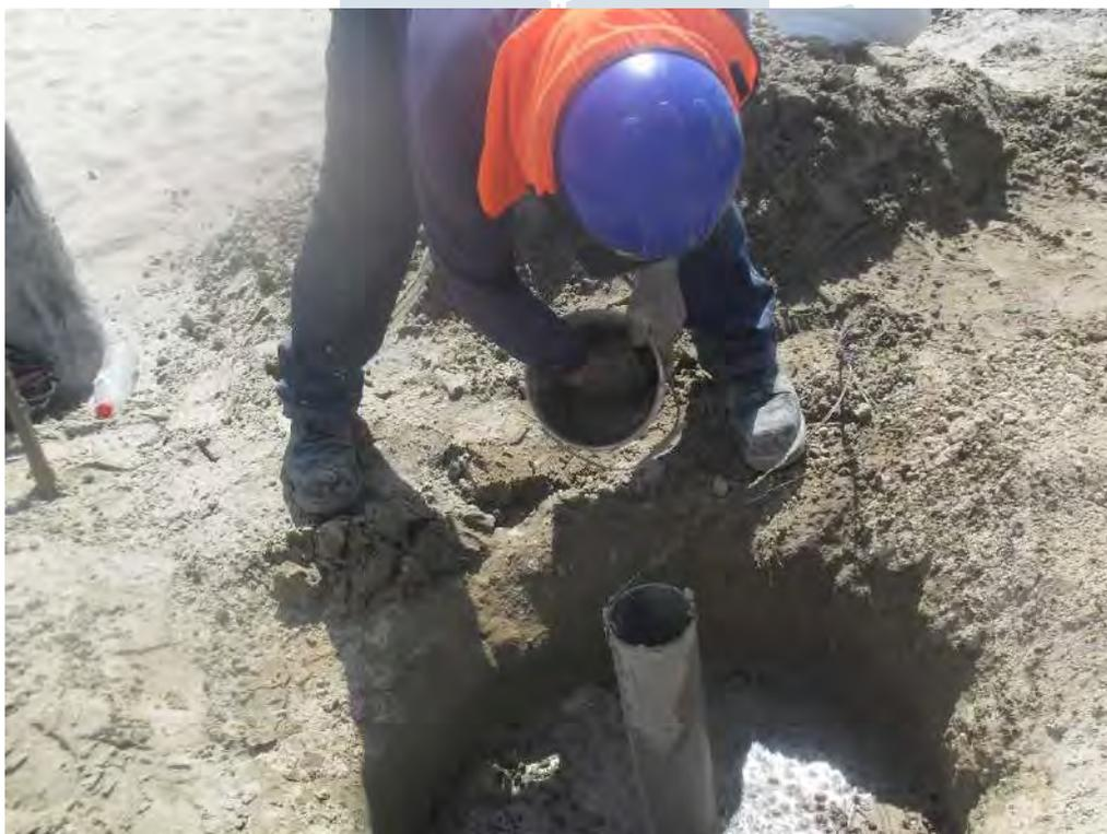
Figura 25. Construcción de pozos a tierra
