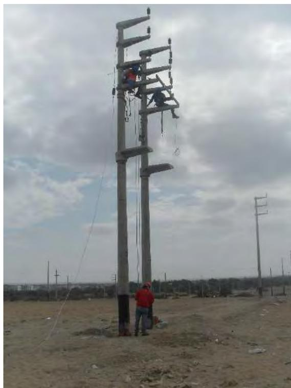
Figura 26. Montaje de armados en media tensión
