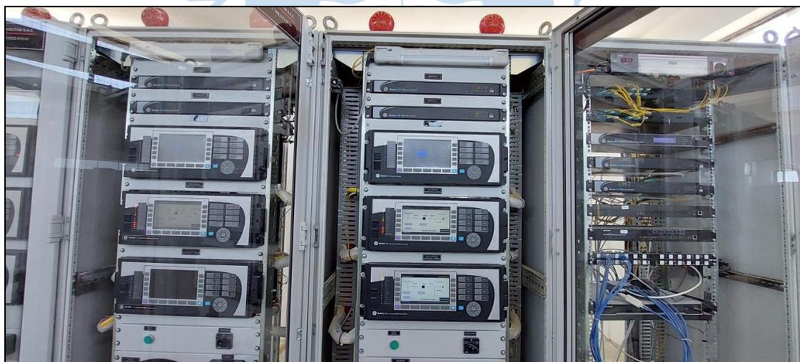
**Nota.** Del inventario a las subestaciones de potencia, que permite revisar controladores de bahía y RTU GE. Subestación Paita Industrial. Tomado “In Situ” (2015).
