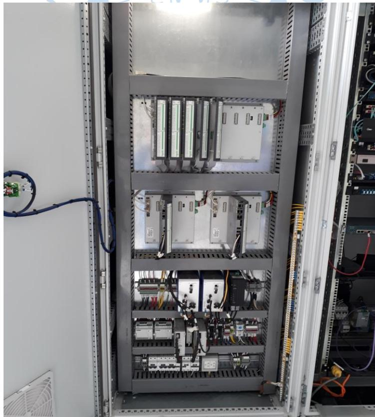
**Nota.** Del inventario a las subestaciones de potencia, que permite revisar en la RTU, las tarjetas de entradas, salidas, CPUs y switches. Subestación Paita. Tomado "In Situ" (2015)
