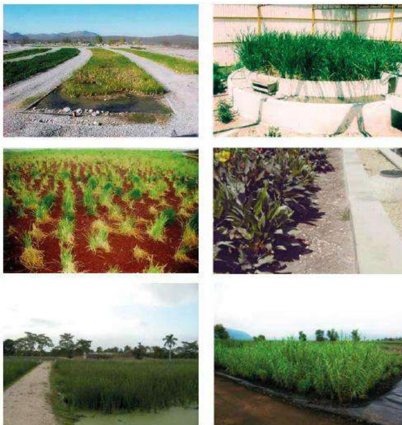
**Figura 38.** Modelos de humedales artificiales subsuperficiales.
