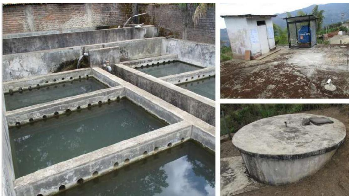
**Figura 29.** Filtros lentos a la izquierda y tanque de cloración a la derecha
