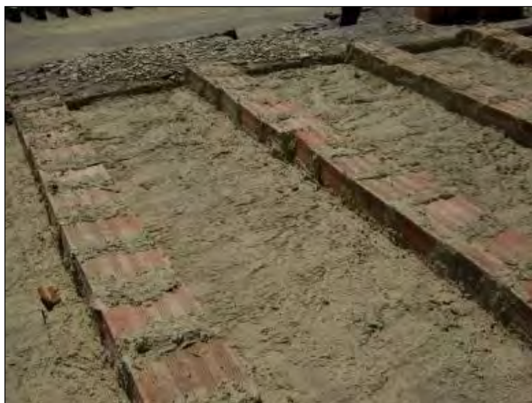
Figura 2.34: Parte superior del horno de ladrillera El Tallán sellado con barro
