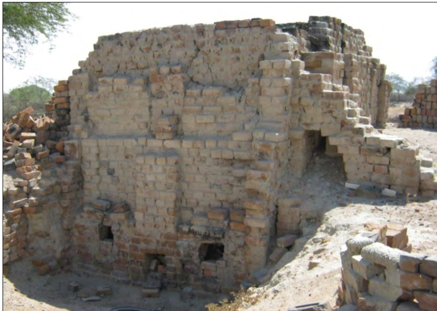
Figura 2.28: Horno para cocción en ladrillera artesanal Piura
