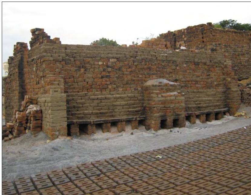
Figura 2.19: Horno para cocción de ladrillos en La Unión
