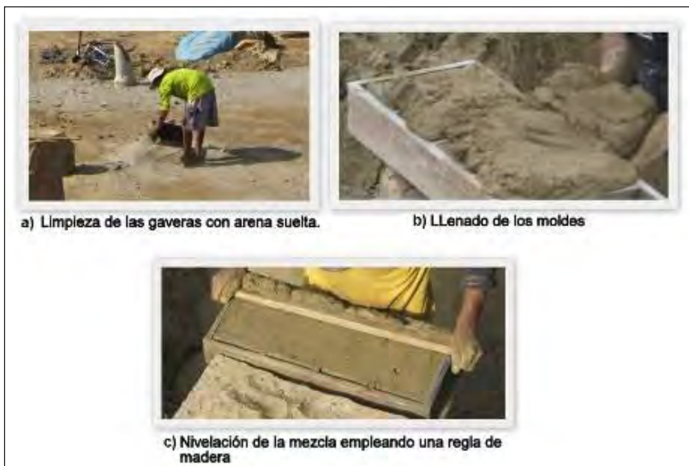
Figura 2.9: Proceso de moldeo de las unidades de albañilería
