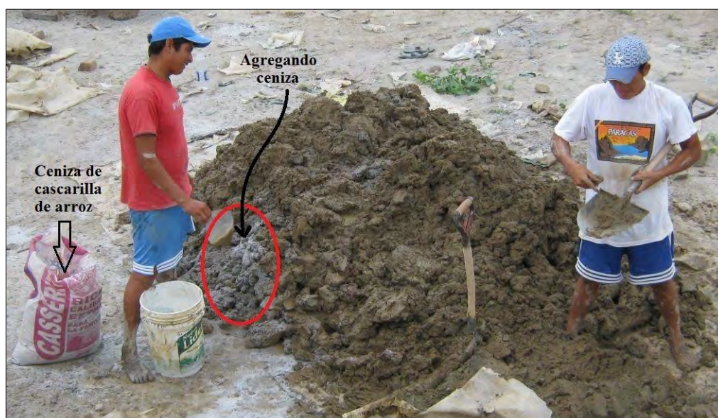
Figura 2.7: Mezcla con ceniza de cascarilla de arroz en Marcavelica
