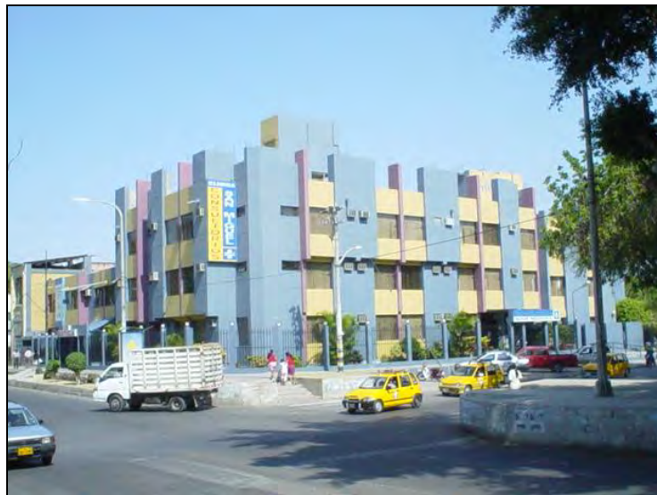
Fotografía 7.7: Una de las causas de la vibración ambiental en la Clínica San Miguel es inducida por el tráfico de autos, camiones, buses y combis.
