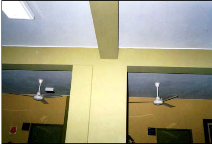
Figura 6.1: Consultorios A (CSM). Vista del sistema estructural en base a pórticos, placas y tabiques.
