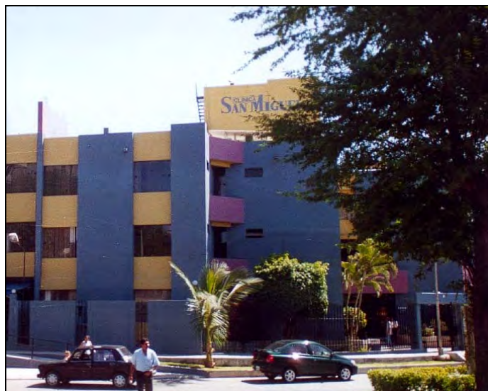
Fotografía 1.3: Clínica San Miguel. Vista de la zona denominada Clínica, donde funciona Emergencia, Hospitalización, UCI, Quirófanos, Rayos X, Cocina, Cafetería, etc. También se observan los accesos al edificio en el Jr. Los Cocos.
