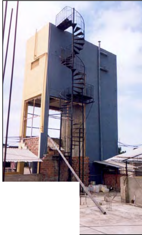
Fotografía 6.4 Irregularidad en altura del edificio de Consultorios A. Obsérvese la Casa de Máquinas del ascensor y el tanque elevado de agua. Foto tomada desde azotea de Consultorios B.
