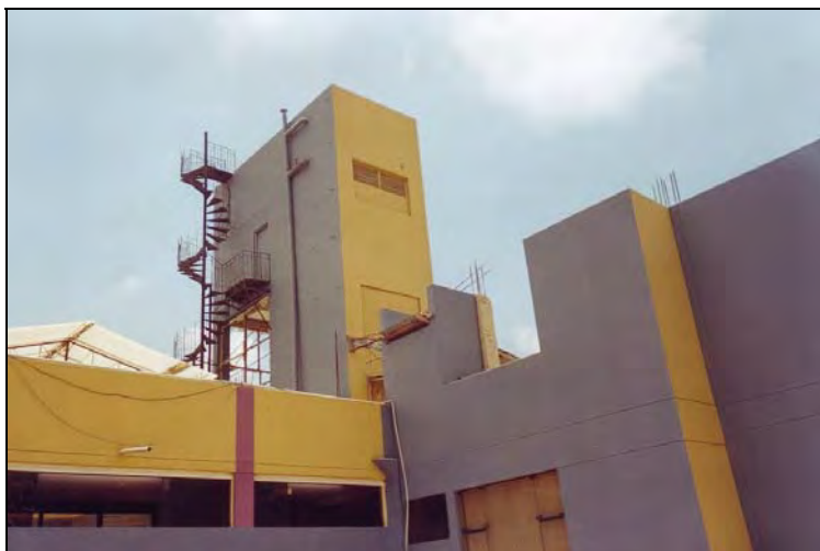
Fotografía 5.3. Irregularidad vertical en la Clínica San Miguel. El 4to piso no acabado de construir favorece esta irregularidad.
