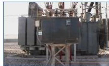
Transformador de 35 MVA - 220 kV
