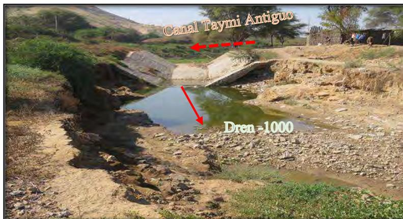
**Figura 17:** Conexión entre canal Taymi y dren principal D-1000
