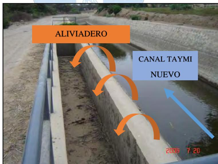
**Figura 14:** Estructuras de entrada ubicadas en la margen izquierda del canal Taymi Nuevo
