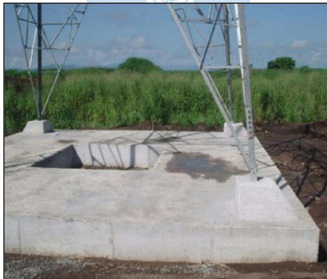
**Figura 36.** Losa de Cimentación.
