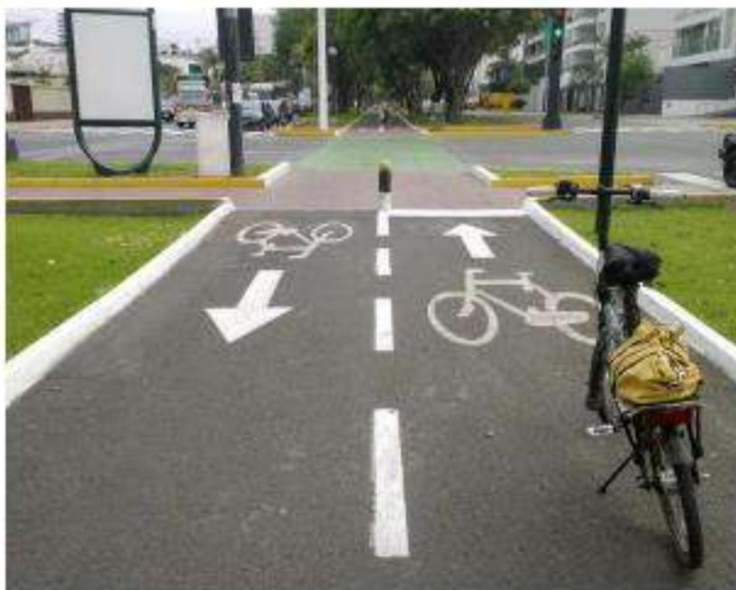
Figura 26. Ciclovía bidireccional con poste delimitador en intersección.
