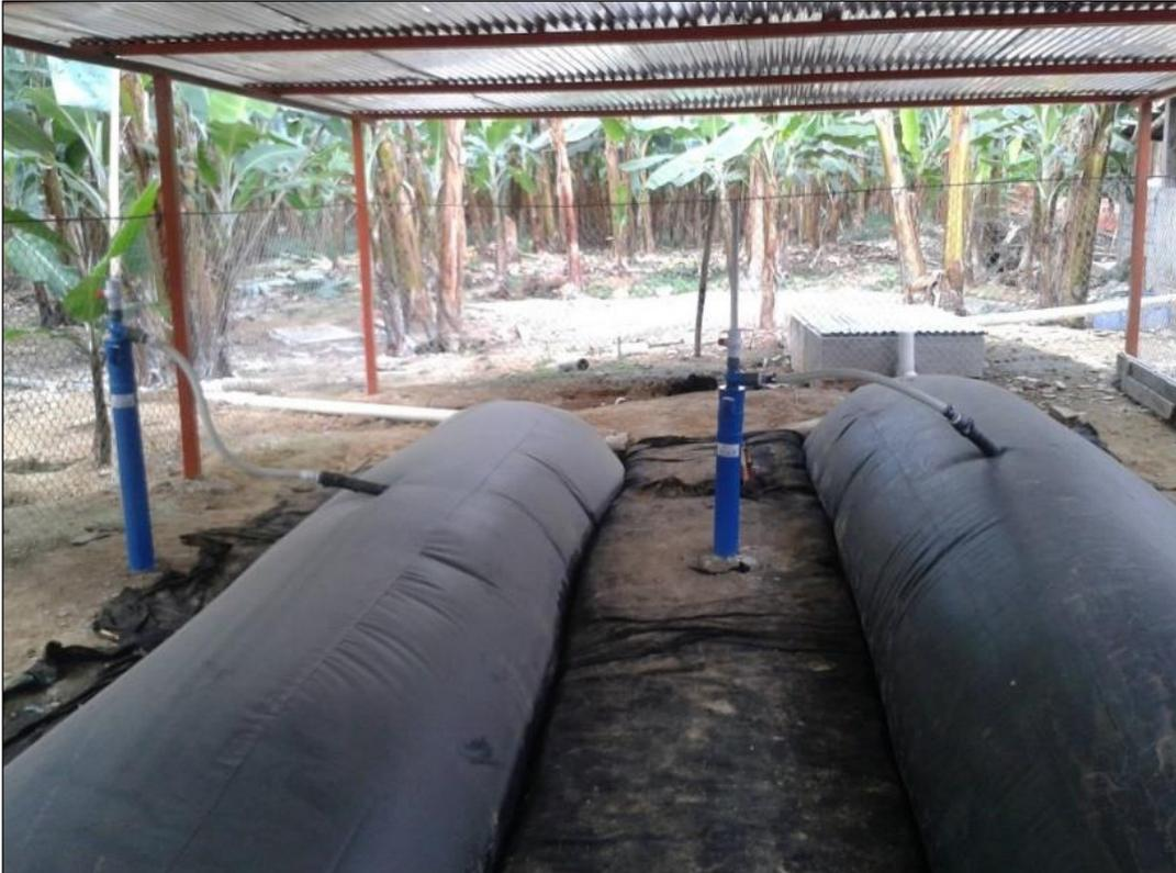
Figura 11. Biodigestores tubulares instalados en Asociación de Productores de Banano Orgánico en Ecuador
