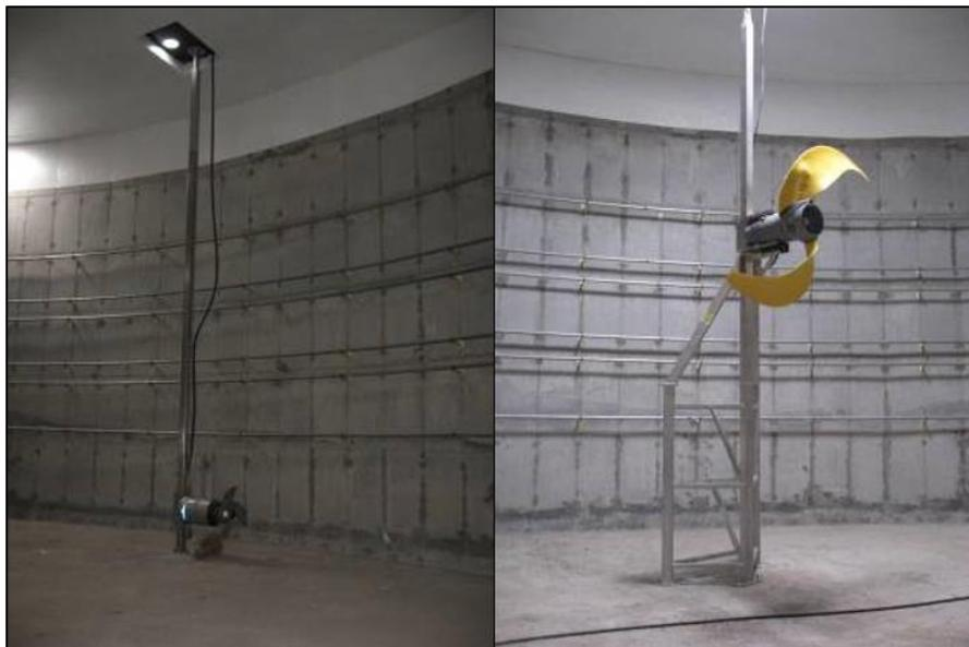
Figura 6. Agitador y sistema de calefacción (en paredes) en reactor de 3000 m<sup>3</sup> (en avícola La Calera). Produce aproximadamente 2500 m<sup>3</sup> de biogás/día.
