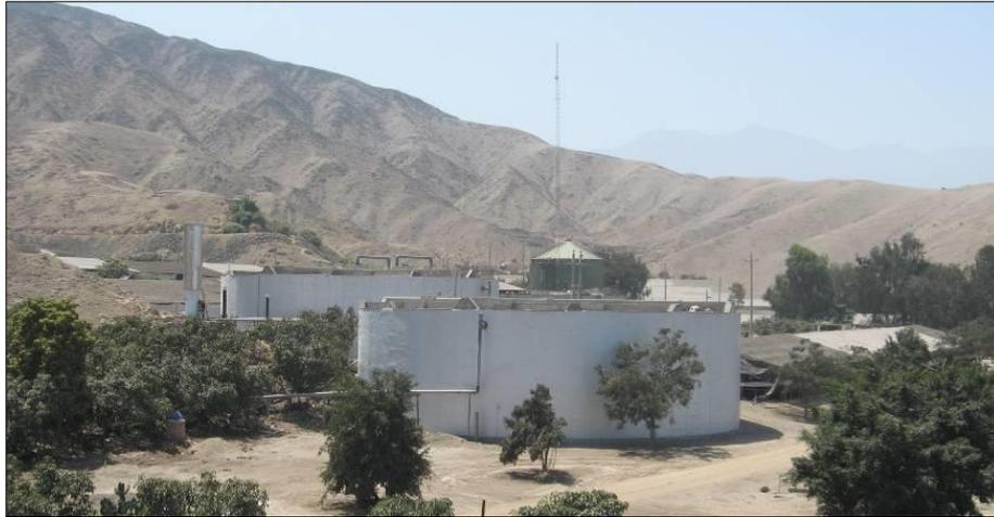
Figura 5. Reactores de 750 m<sup>3</sup> y 1500 m<sup>3</sup> en avícola La Calera (Chincha, Perú). Producen entre 1500 y 2000 m<sup>3</sup> de biogás/día a partir de estiércol aviar.
