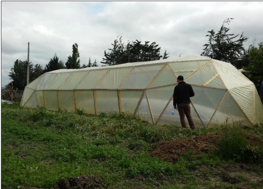
Figura 10. Aumento y estabilización de temperatura de biodigestor mediante efecto invernadero en granja vacuna en Santiago de Chile.
