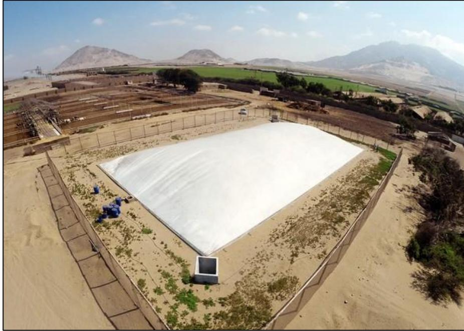
Figura 4. Biodigestor de laguna cubierta de 4500 m<sup>3</sup> instalado en un establo ganadero en Trujillo, Perú.
