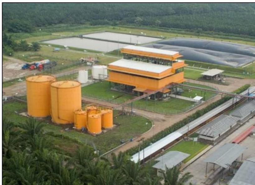
Figura 3. Biodigestores de laguna cubierta. Genera 2MW, usando como sustrato residuos de la industria de la palma aceitera en Tocache, Perú (Grupo Romero).
