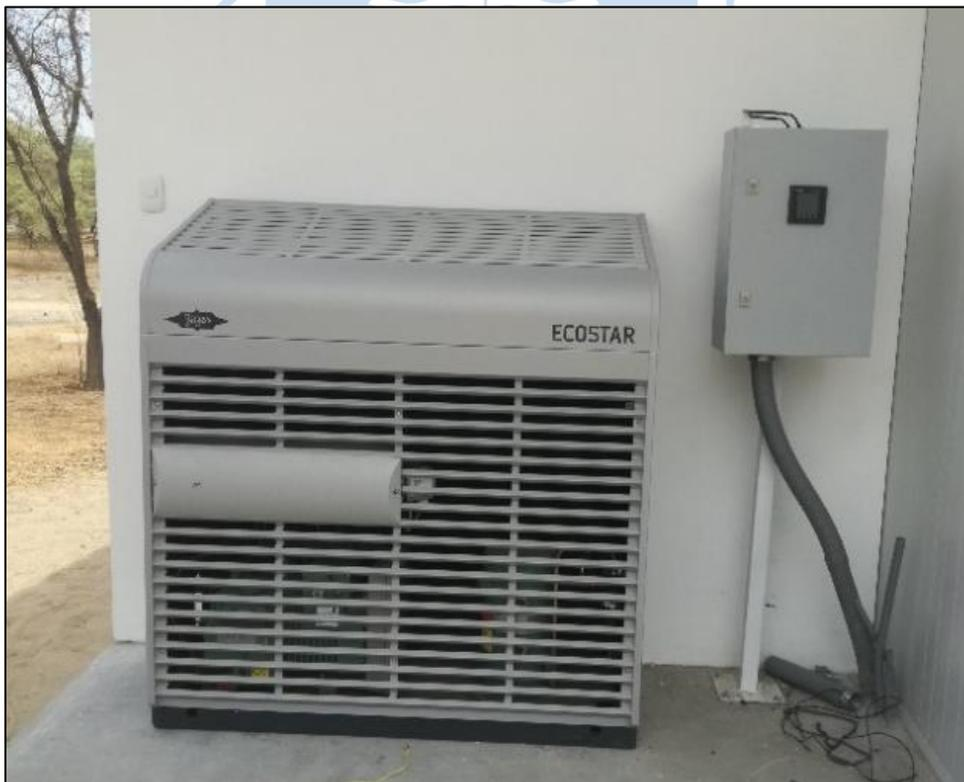
**Figura 22.** Condensador Bitzer y Tablero de potencia. [Fuente propia].
