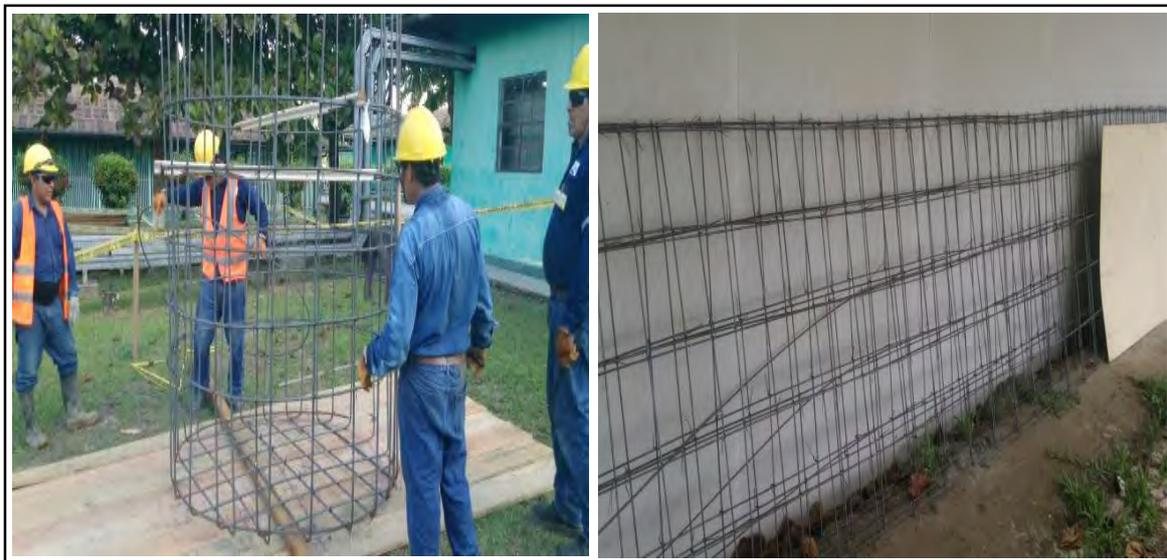
Figura N° F6: Habilitación de malla de acero para buzones y pavimento
