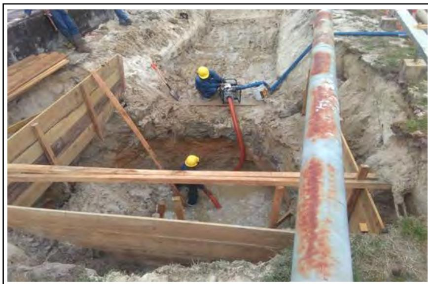
Figura N° F8: Bombeo de agua de filtración y lluvia
