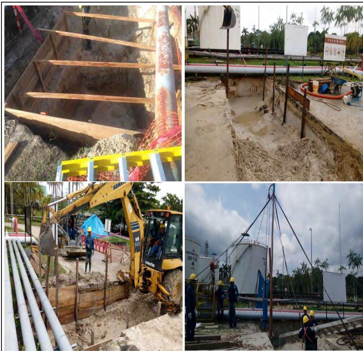
Figura N° F7: Entibado de paredes de zanja
