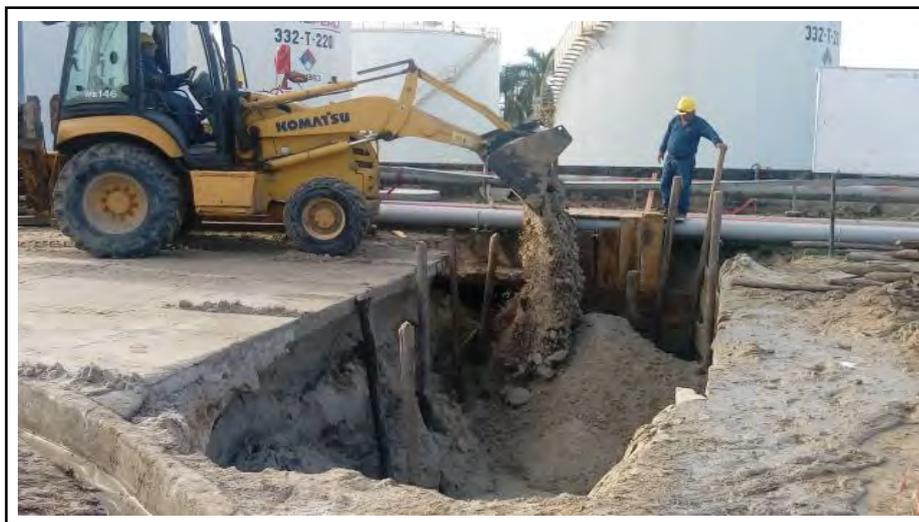
Figura N° F10: Relleno de zanja con material seleccionado
