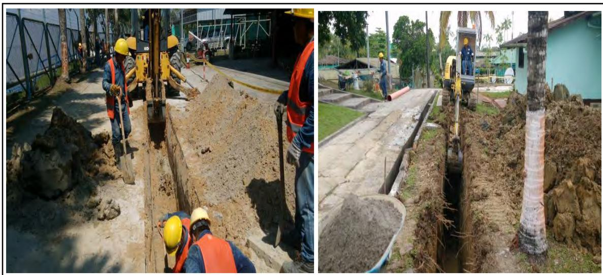
Figura N° F16: Excavación de zanjas
