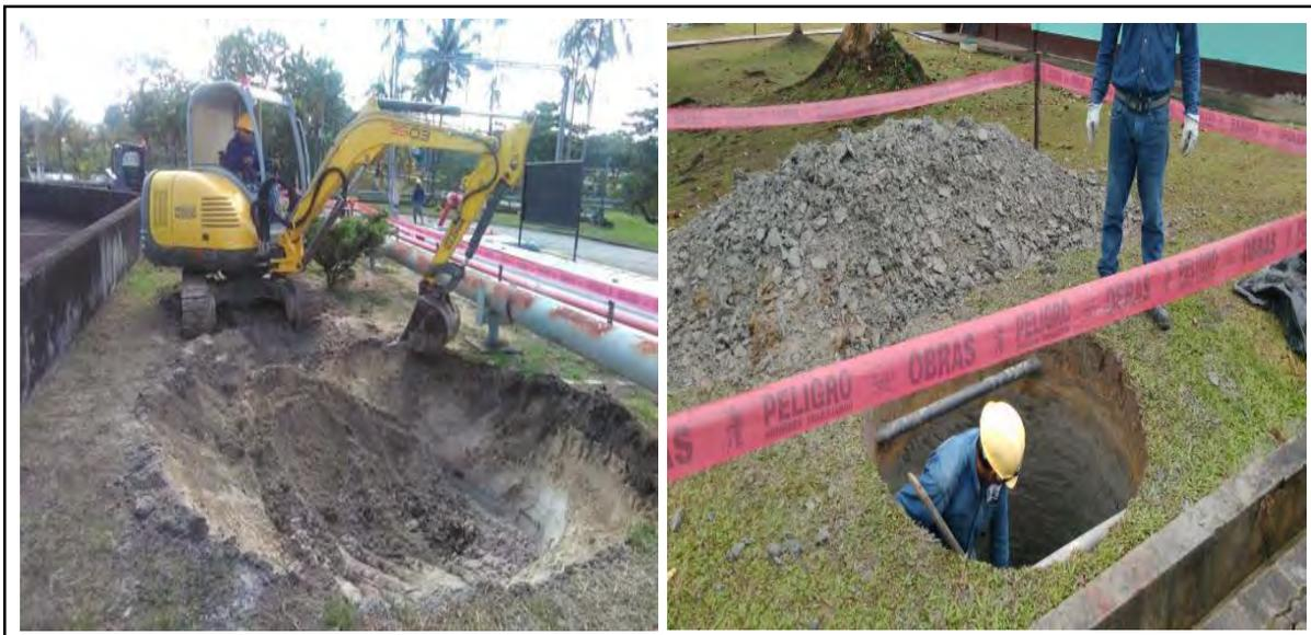
Figura N° F5: Excavación de zanja para buzones
