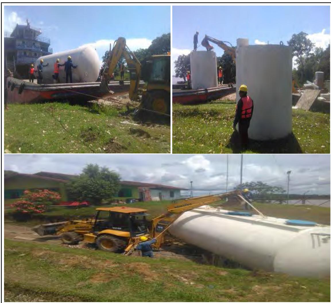
Figura N° F21: Ingreso de equipamiento para PTAR
