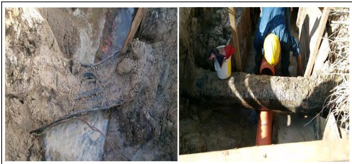
Figura N° F22: Interferencias de cables eléctricos y tubos de concreto
