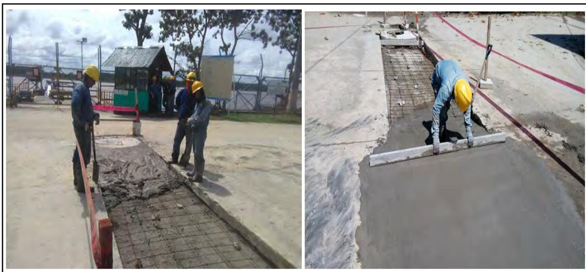
Figura N° F19: Vaciado de losa
