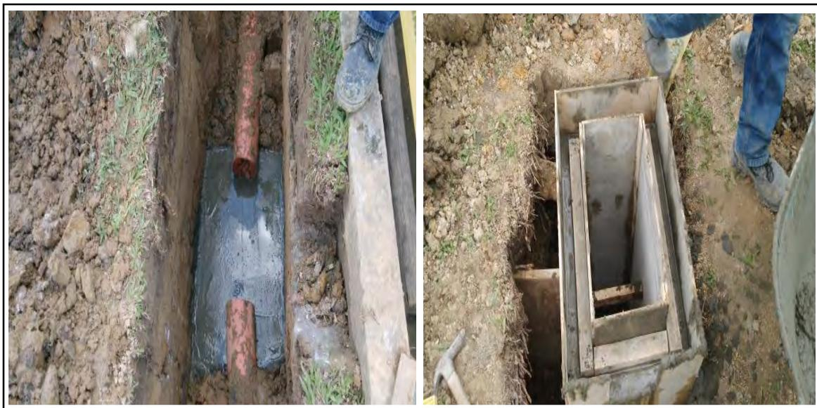
Figura N° F17: Instalación de cajas de registro
