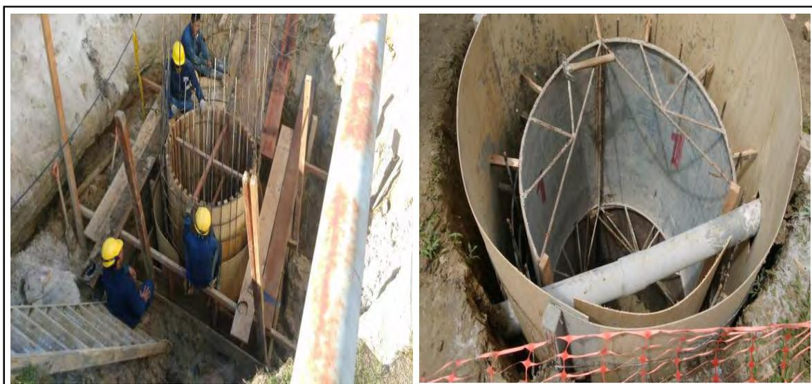
Figura N° F9: Encofrado de buzones
