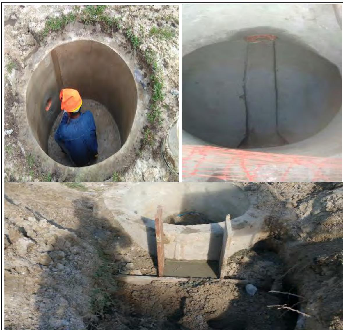
Figura N° F12: Solaqueado, media caña y dado de concreto en buzón
