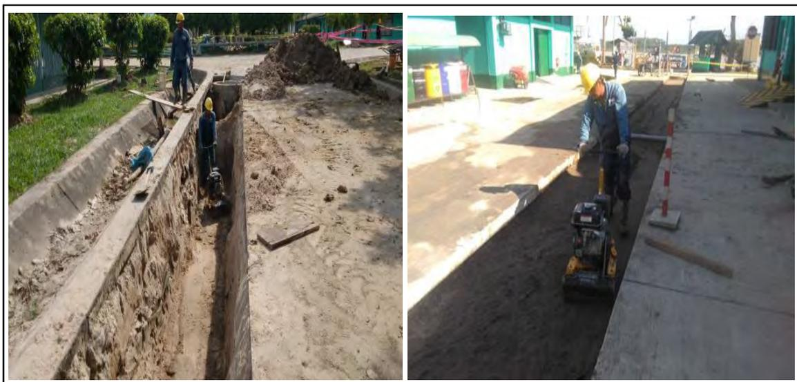
Figura N° F18: Compactación de zanjas
