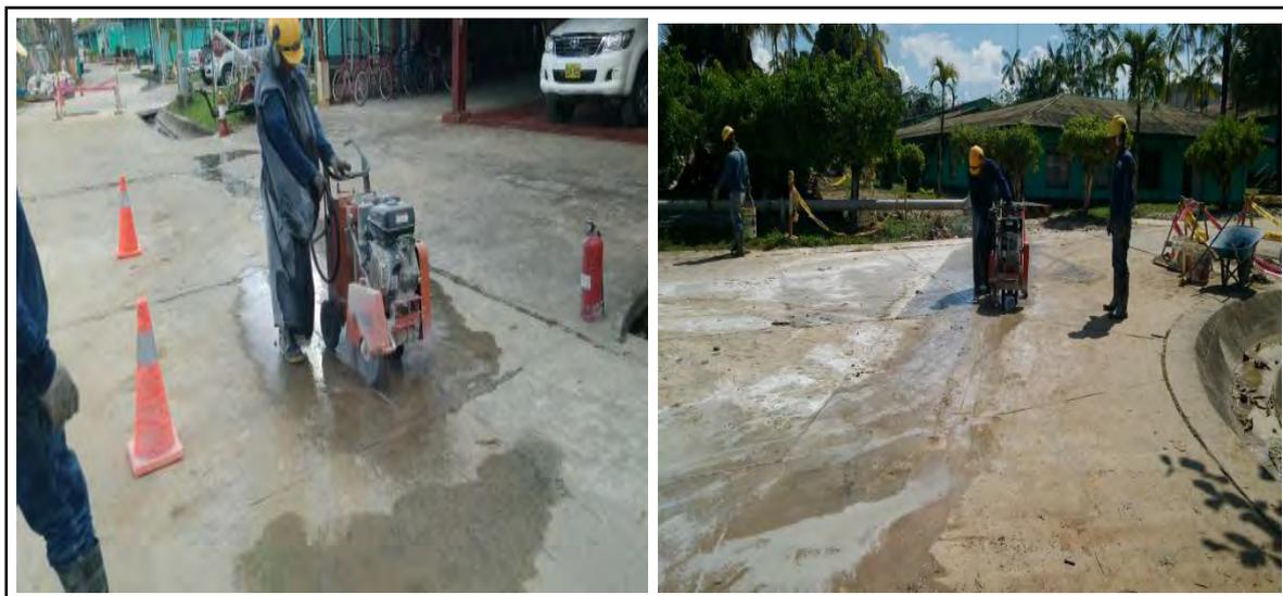
Figura N° F14: Corte de pavimento
