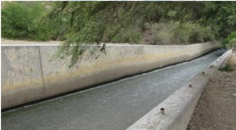
**Figura 41.** Transición de entrada de la rápida hidráulica.
