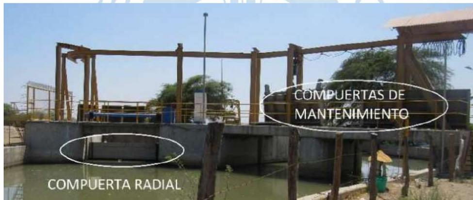
**Figura 36.** Bocatoma de la CH de Curumuy.
