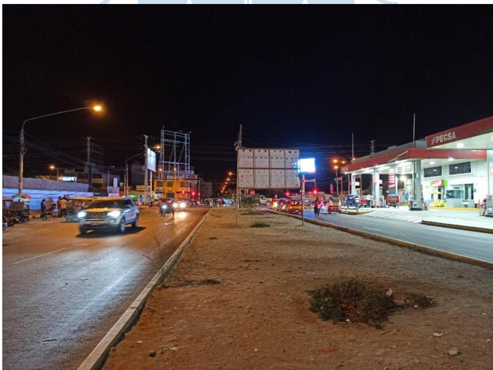
Figura 37. Vista longitudinal de los primeros metros de la vía. A la izquierda, se observan dos de las tres únicas luminarias instaladas en ese lado a lo largo de todo el tramo.
