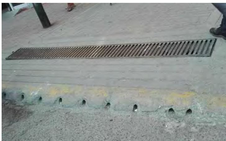
**Figura 104. Drenaje pluvial en el pasaje peatonal de la calle Ayacucho**
