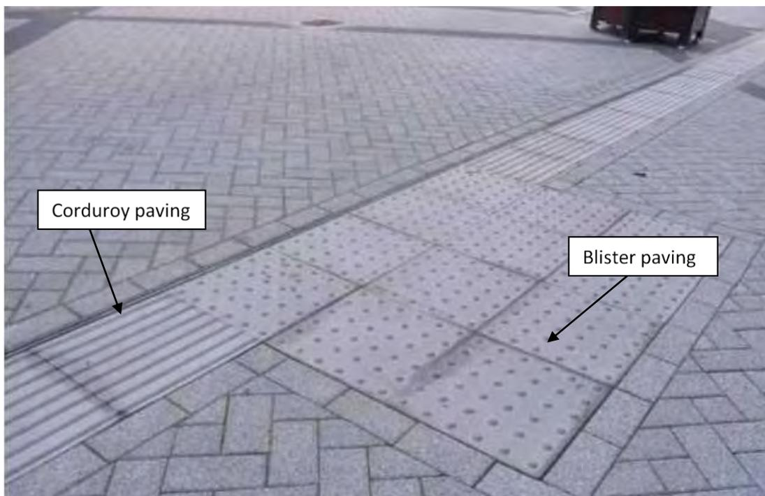
**Figura 19.- Transición de corduroy paving a blister paving.**
