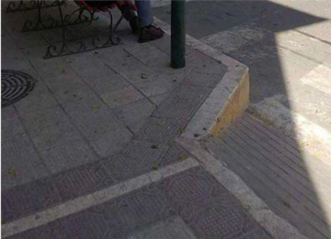
**Figura 49.- Vereda con superficie de losetas de 0.23m x 0.23m en esquina de la Av. Grau con la calle Junín.
