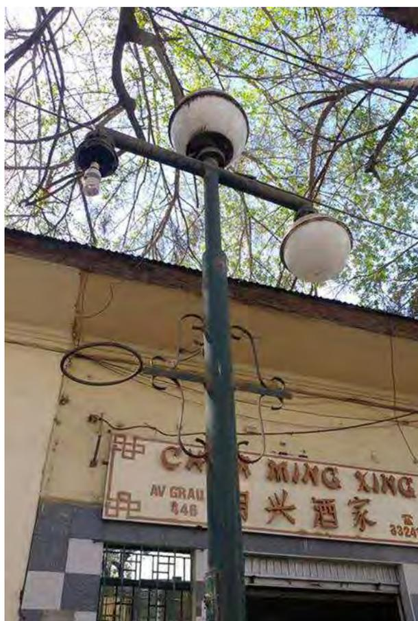
**Figura 52.- Farol de acero en mal estado en la Av. Grau entre la calle Junín y la Av. Loreto.
