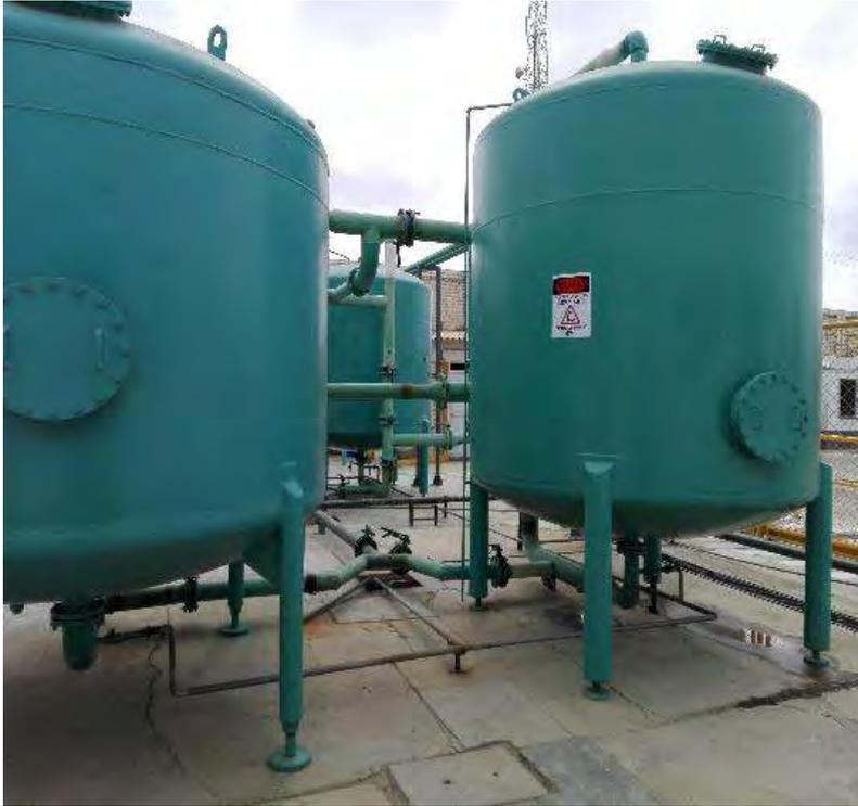
Ilustración 4. Filtros de carbón y arena.
