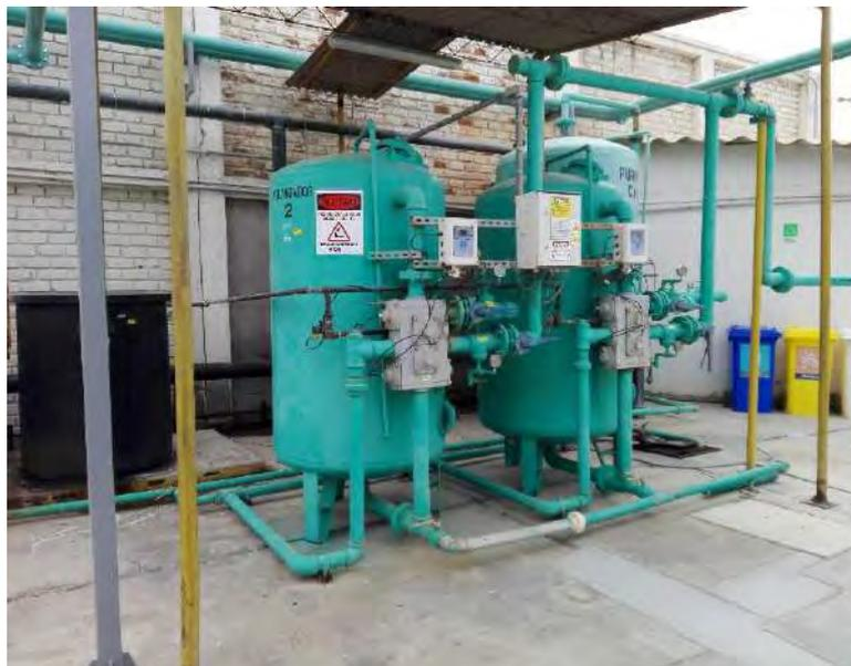
Ilustración 2. Tanques purificadores.
