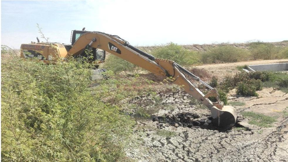
**Imagen E. 3.** Extracción de lodos de laguna primaria con maquinaria de EPS Grau S.A.
