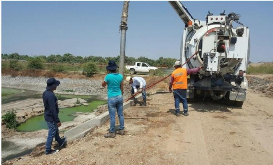
**Imagen E. 4.** Limpieza de las estructuras de ingreso con el equipo hidrojet
