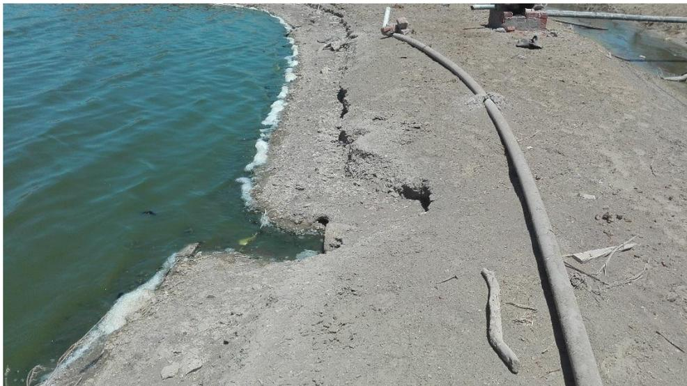
**Imagen B. 2.** Las estructuras de ingreso de la PTAR Los Órganos se encuentran en malas condiciones y los bordes de las lagunas están perdiéndose
