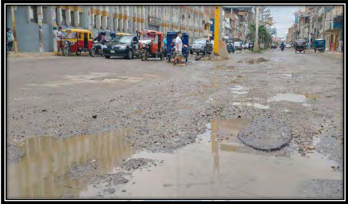
Figura 49. Deterioro de la av. Tumbes en la intersección con la calle Abad Puell.
