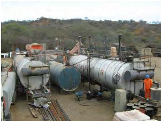
**TANQUES DE MODIFICACION Y ALMACENAMIENTO DE ASFALTO**
