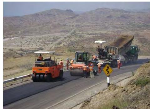
**COLOCACION Y COMPACTACION MEZCLA ASFALTICA EN CALIENTE MODIFICADA CON POLIMEROS SBS**
