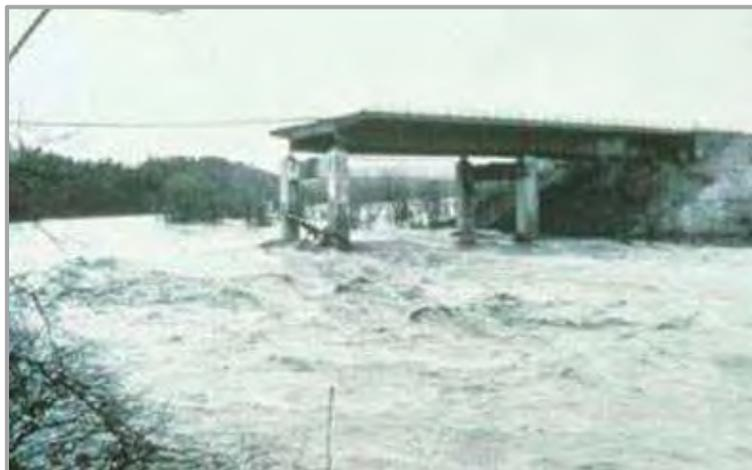
**Fig. 1.1 Colapso del puente sobre Schoharie Creek**
