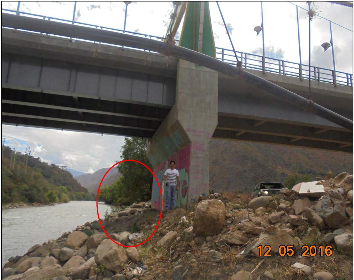
**Fig. B-2 Material rocoso que protege el estribo del puente Colpa Alta**
