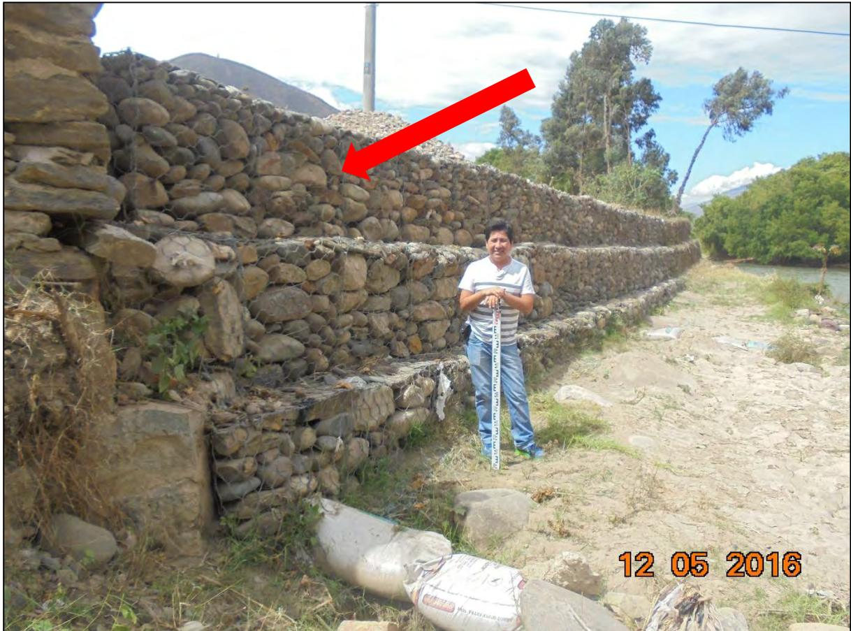
**Fig. B-3 Margen del río Huallaga con gaviones para protección del estribo del puente Colpa**
