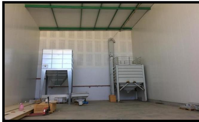
Figura 14. Tolva del alimentador en el almacén en construcción
