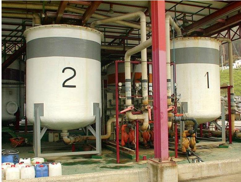
ILUSTRACIÓN 13: TANQUES DE NEUTRALIZACIÓN
