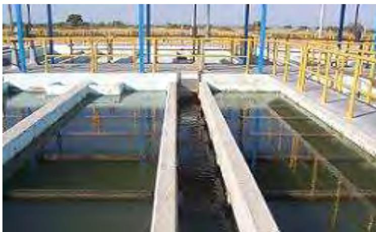
**Figura 3.** Decantador estático de flujo laminar
