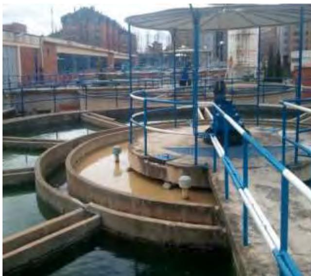
**Figura 4.** Decantador circular
