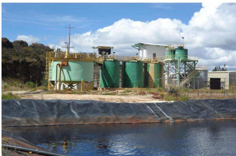
Figura 17. Vista de los tanques de neutralización y el tanque sedimentador
