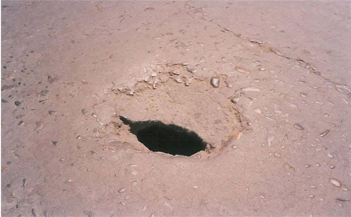
**Figura 5.5 Hueco profundo en la losa de concreto**
