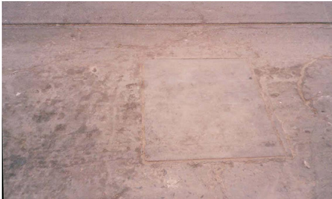
**Figura 5.8 Parche de concreto de cemento portland en buen estado**
