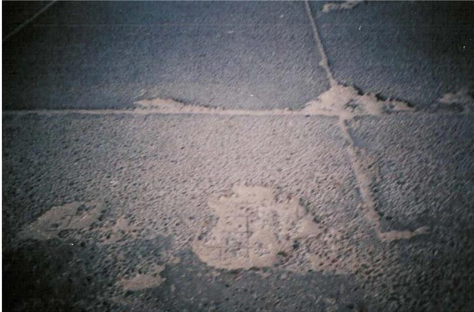
**Figura 5.17 Desprendimientos de trozos de concreto (baches)**
