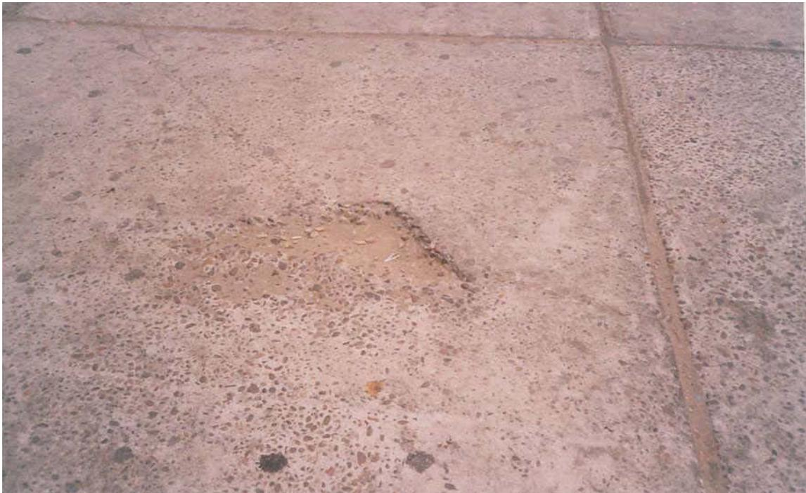
**Figura 5.6 Desintegración de la superficie de concreto**
