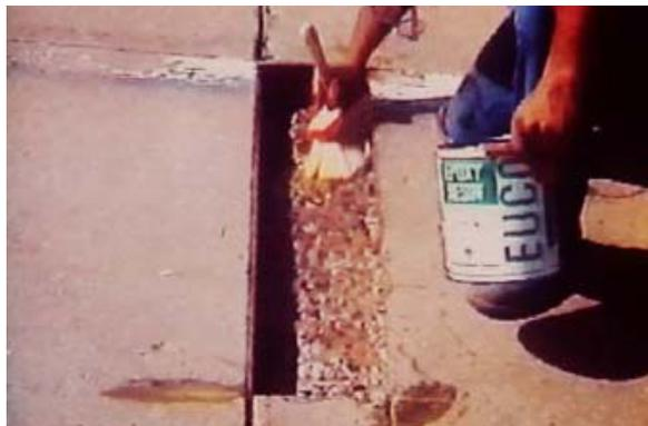
**Figura 3.4 Aplicación de puente de adherencia en reparación \***
