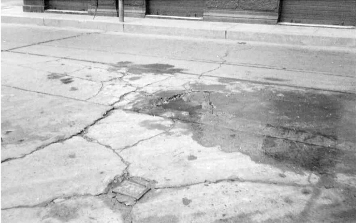
**Figura 5.1 Asentamiento de la losa de concreto**
