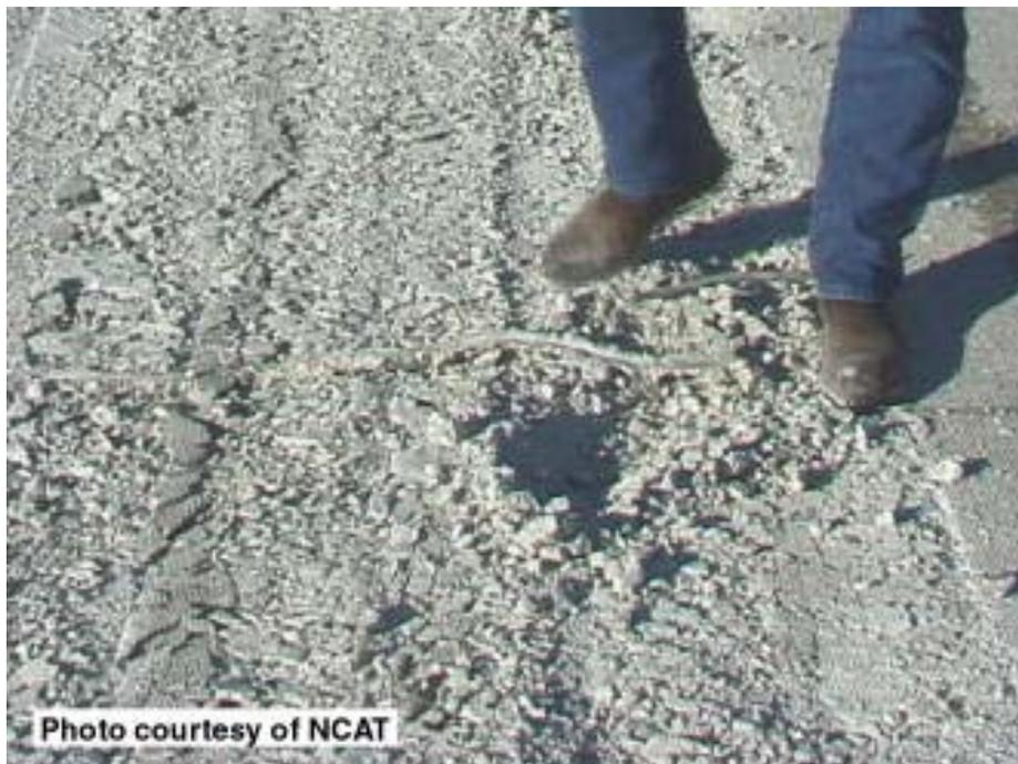
**Figura 4.10 Losa de concreto después de ser triturada \***
