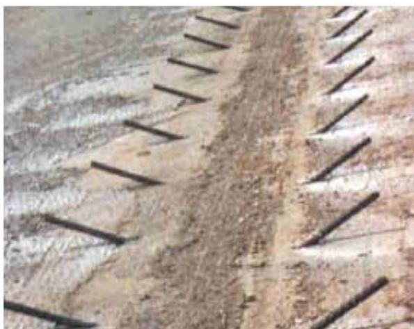
**Figura 3.7 Barras insertadas en las perforaciones conteniendo epóxico\***
