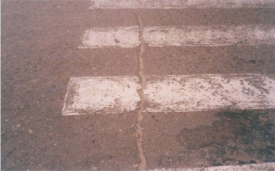
**Figura 5.11 Reflexión de fisuras**
