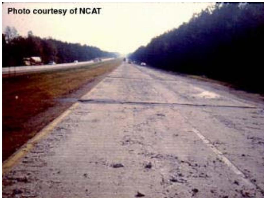
**Figura 4.11 Losa de concreto después de ser fisurada \***
