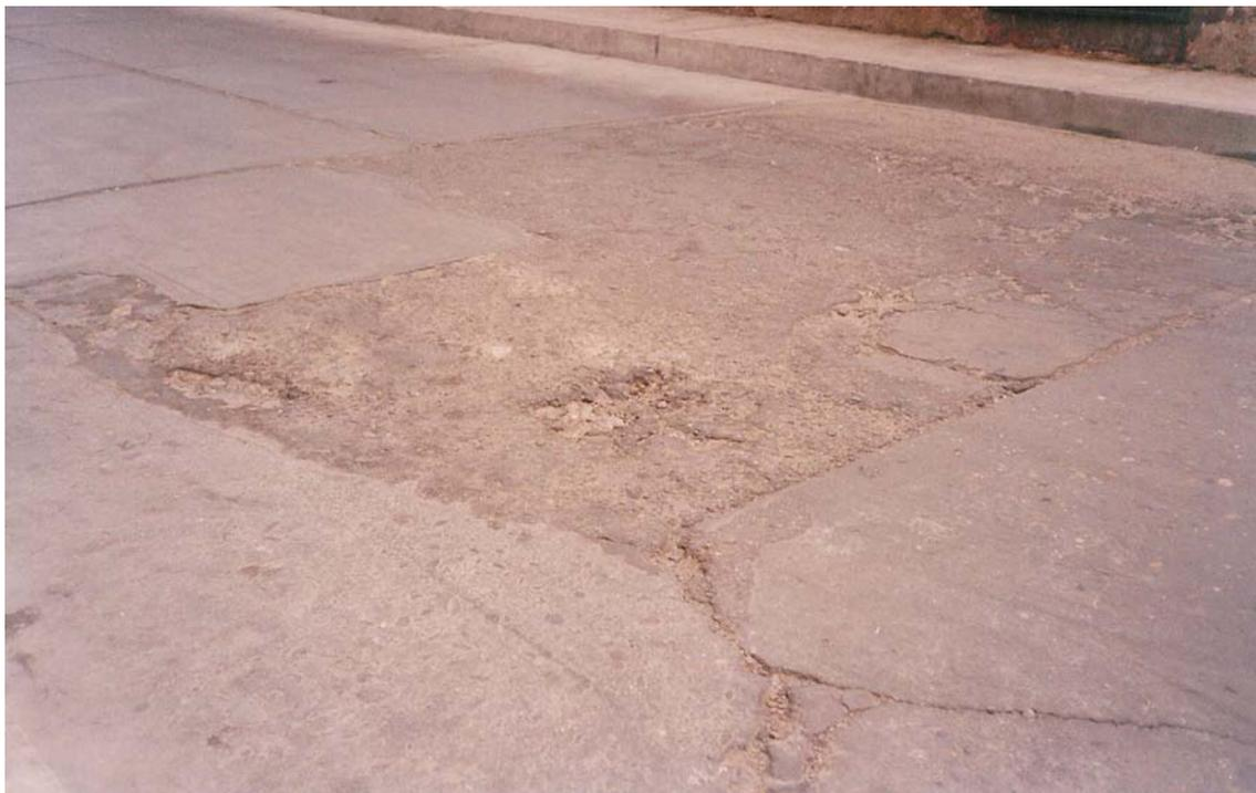
**Figura 5.7 Parche de concreto asfáltico deteriorado**
