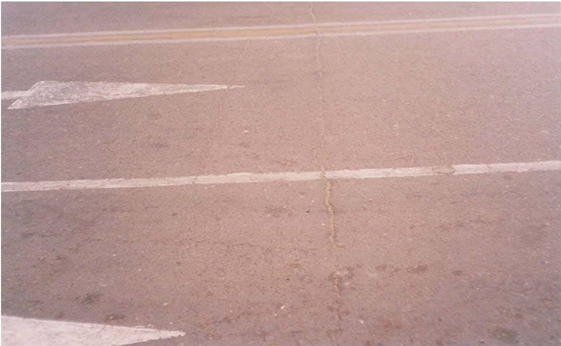
**Figura 5.12 Reflexión de fisuras**
