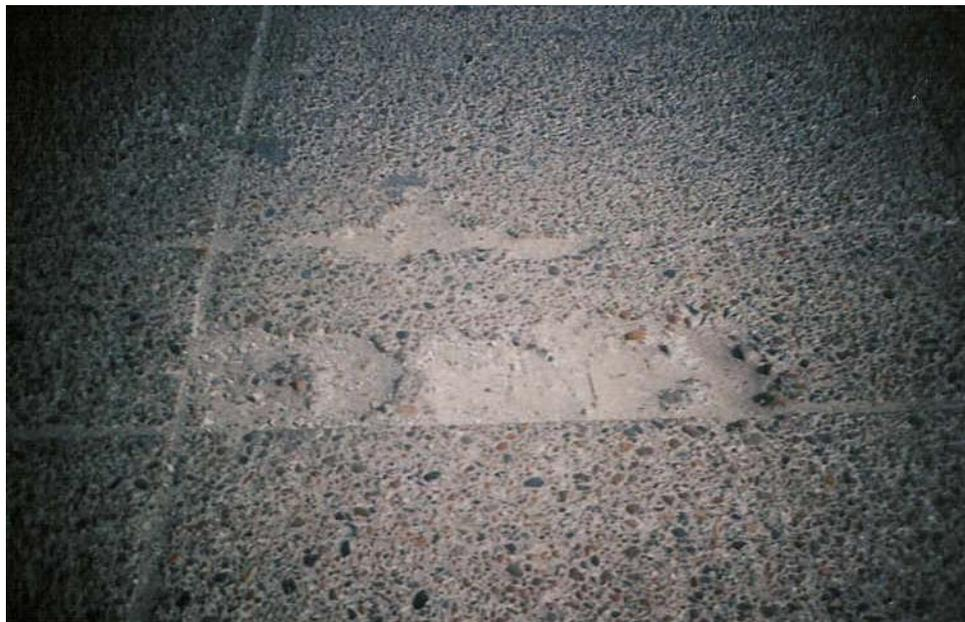
**Figura 5.18 Desprendimientos de trozos de concreto (baches)**
