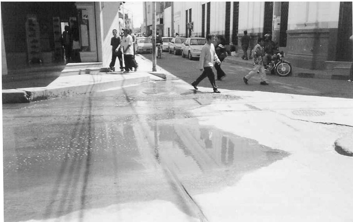
**Figura 5.2 Hundimiento de la losa y colapso del sistema de alcantarillado**
