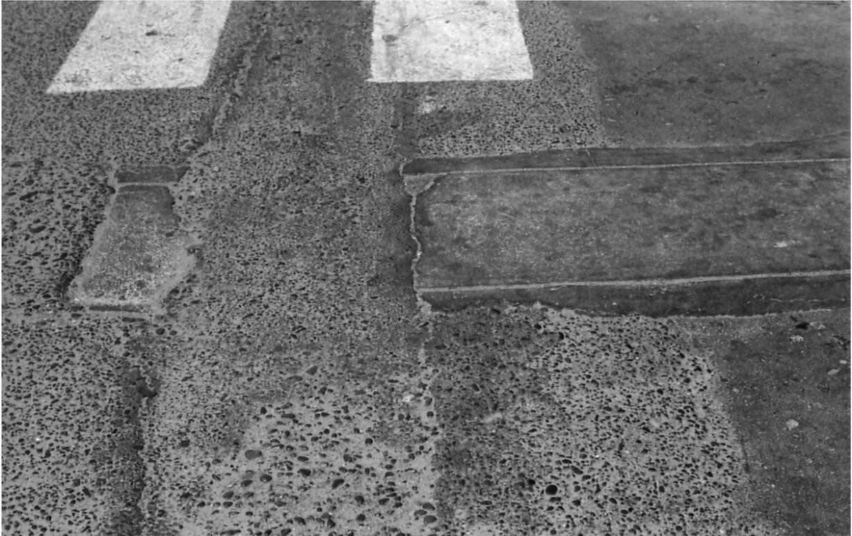
**Figura 5.16 Transición inadecuada entre un parche de concreto y la sobrecapa de refuerzo**
